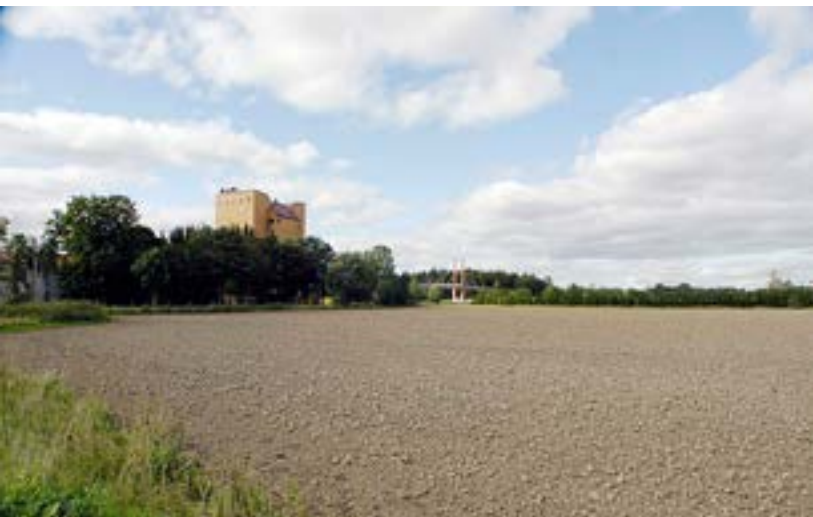
Saltå kvarns kvarnbyggnad och gångbron, Järna. Foto: Emma Tibblin
