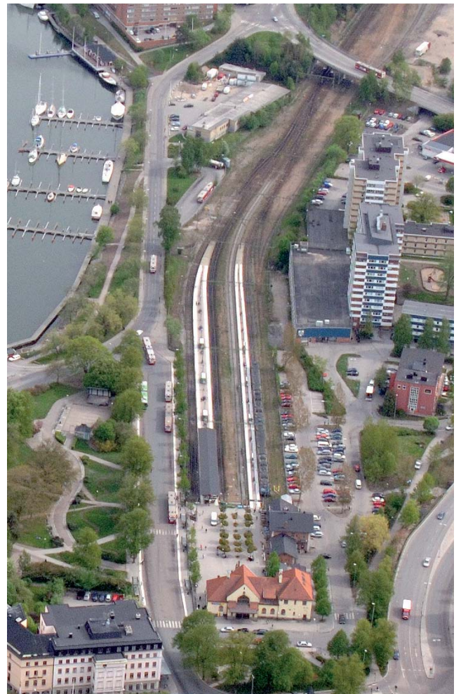
Spårområdet vid Södertälje centrum
