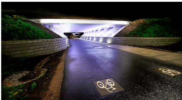
Exempel på gång- och cykeltunnel i Linköping. Gående och cyklister är separerade genom olika markbeläggning, tunneln är belyst och sidområdena röjda vilket skapar god sikt. Källa: www.tindradesign.nu
