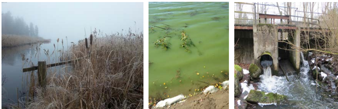
Figur 3: T.v; Utloppet från Lilla Måsnaren till Måsnaren, mitten; algblomning vid Eklundsnäsbadet 2014, t.h.; Måsnarens regleringsdamm från 1954 vid Sågstugan. Foto: Carolina Hillerdal, Södertälje kommun.
