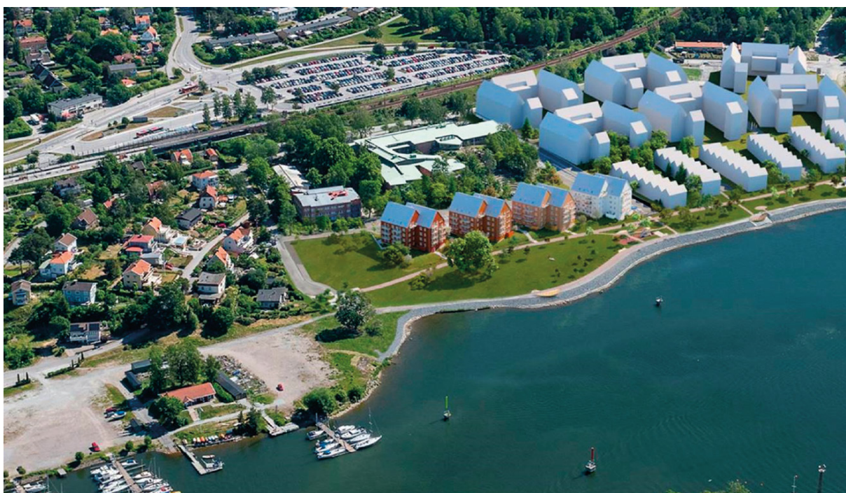
Visionsbild Pågående och planerad utbyggand av Igelsta strand. De fyra Kanalhusen planeras stå klara 2021. (Bild: JM)
