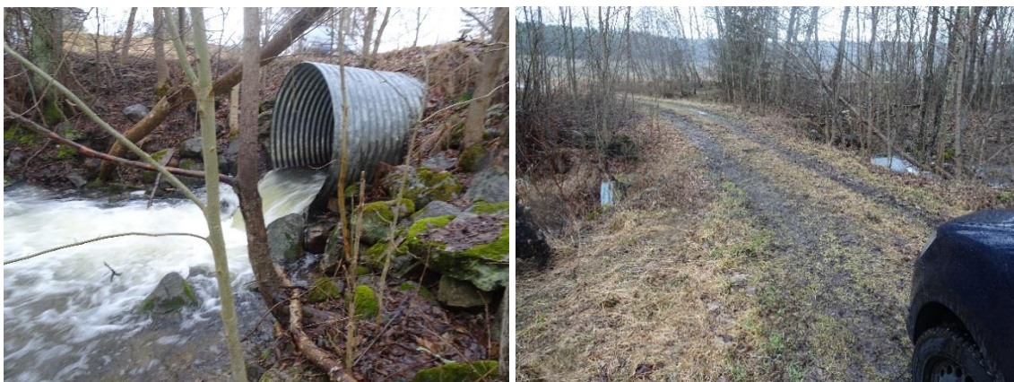
Figur 8: Nedströms vy av plåttrumman. Vy över traktorväg och trummans läge.
