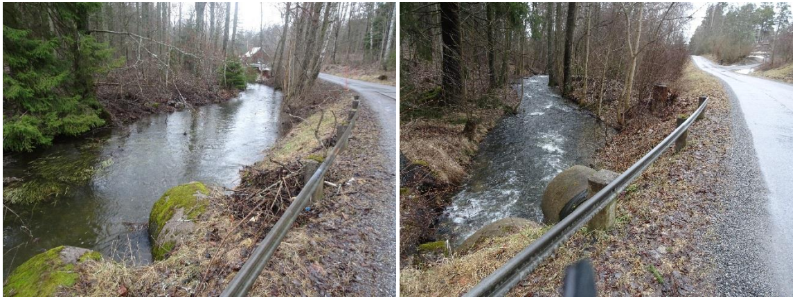
Figur 4: Uppströms och nedströms vy av betongtrummor.
