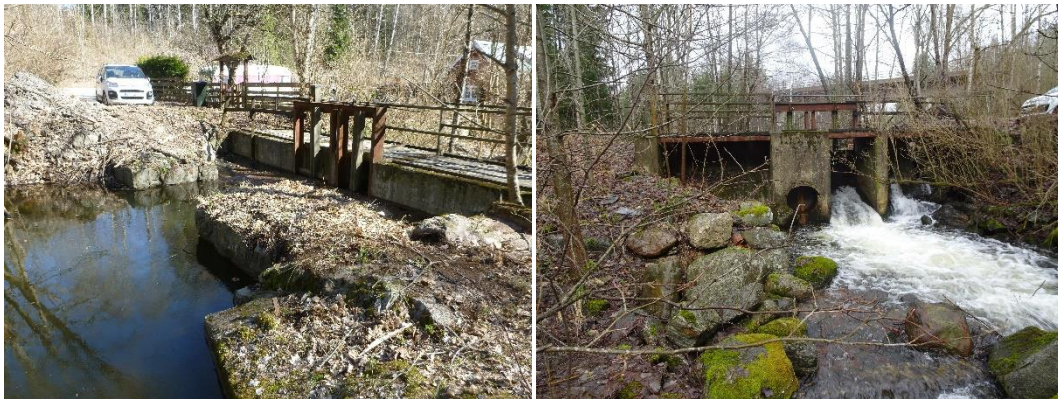
Figur 3: Damm i Måsnarens utlopp, Ålöström. Uppströms och nedströms vy.
