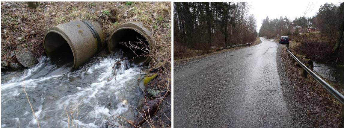
Figur 5: Nedströms vy av betongtrummor. Vy över väg och trummornas läge.
