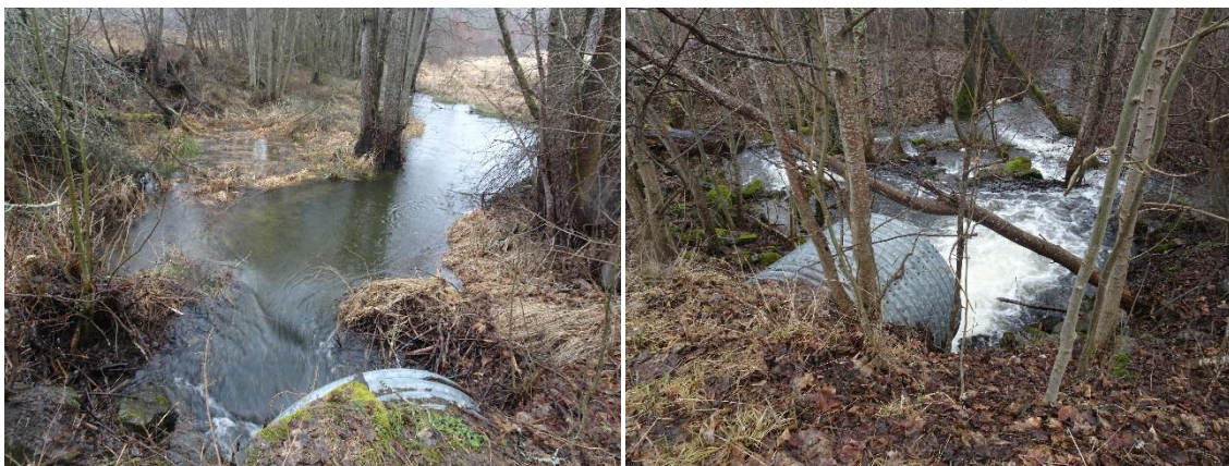
Figur 7: Uppströms och nedströms vy av plåttrumman.
