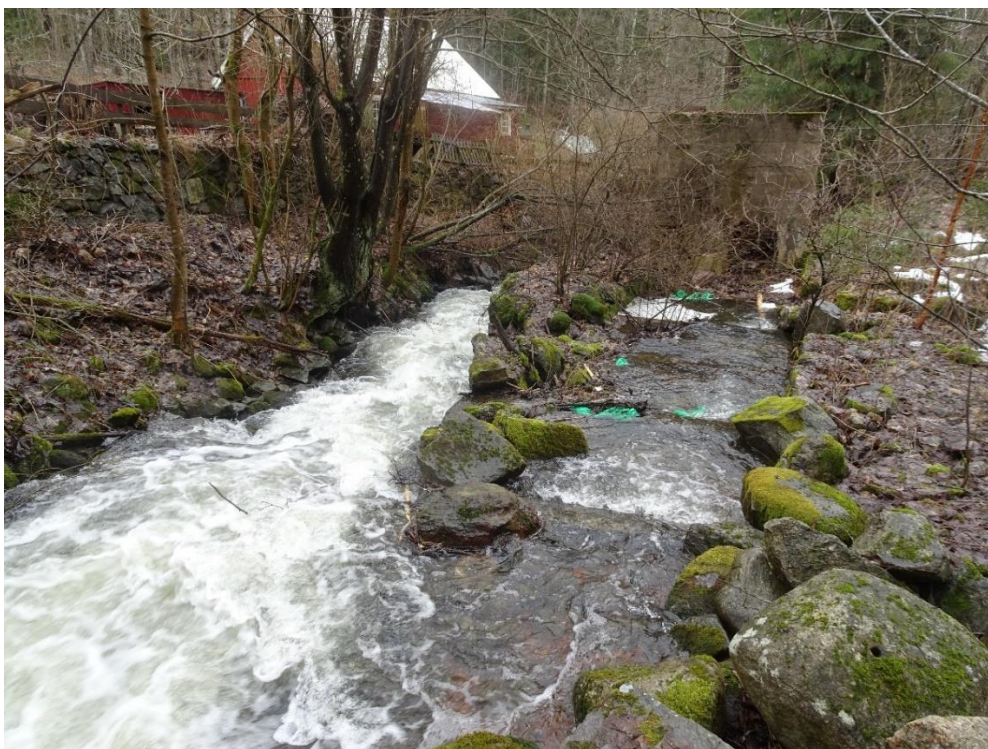
Figur 10: Området nedströms befintlig damm. Rester av det gamla sågverket syns till höger i bild.
