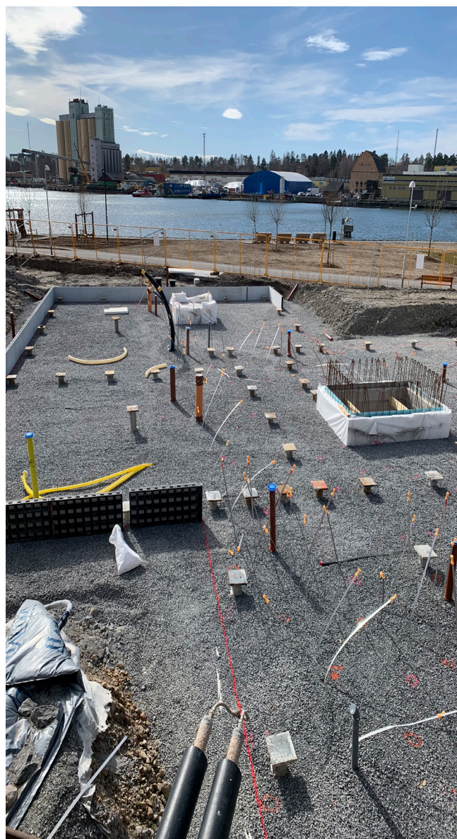
Grundläggning för Kanalhusen
