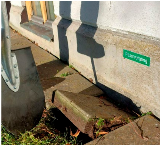
Reservutgången ska öppnas upp även från utsidan. Ta bort markbeläggning med hjälp av spade.
