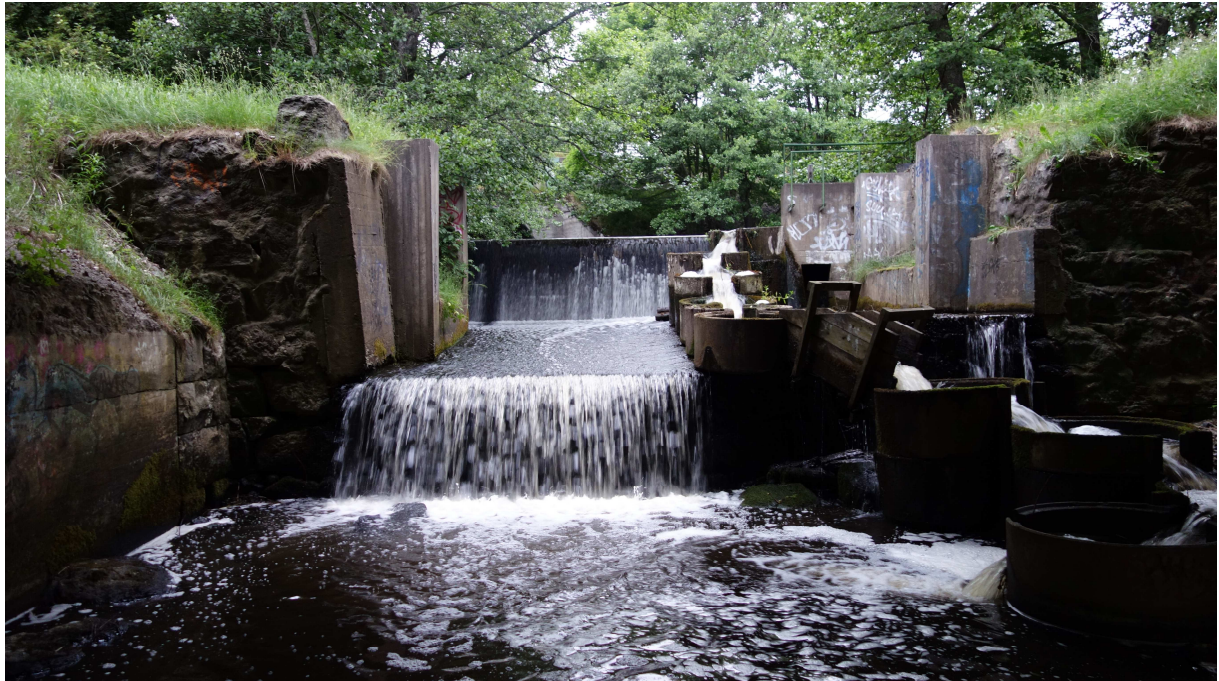
Bild 18. Järnadammen med den befintliga fiskvägen 2014-06-03. Foto Jonas Edlund.
