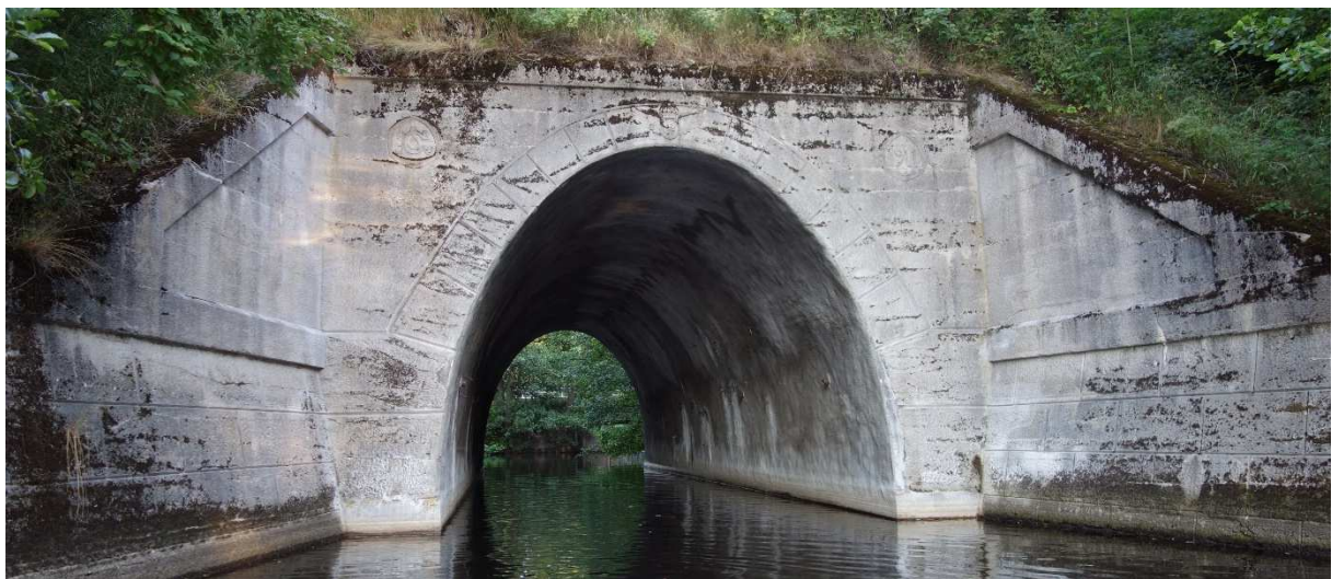
Bild 21. Valvet i järnvägsbron uppströms Järnadammen 2014-07-09. Foto Jonas Edlund.
