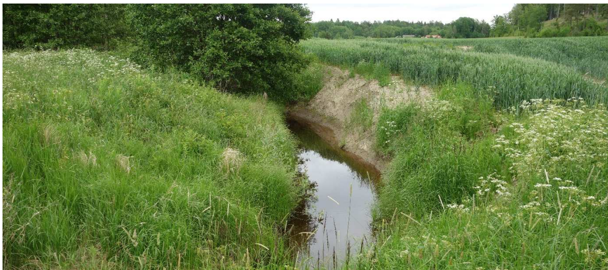
Bild 8. Sänkt och omgrävd sträcka med erosionskänslig dikeskant i Ogaåns övre delar 2014-06-17. Foto Jonas Edlund.
