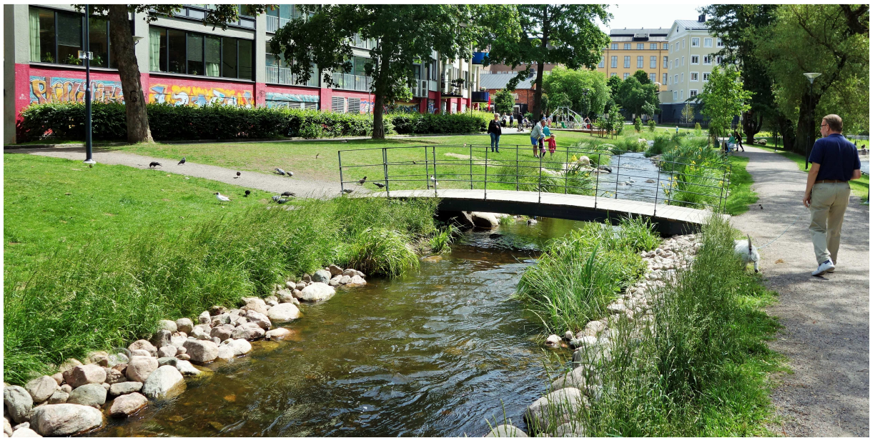
Bild 26. Exempel på anlagd strömvattenfåra. Fotografiet visar omlöpet i Strömsparken i Norrköping. Foto Jonas Edlund
