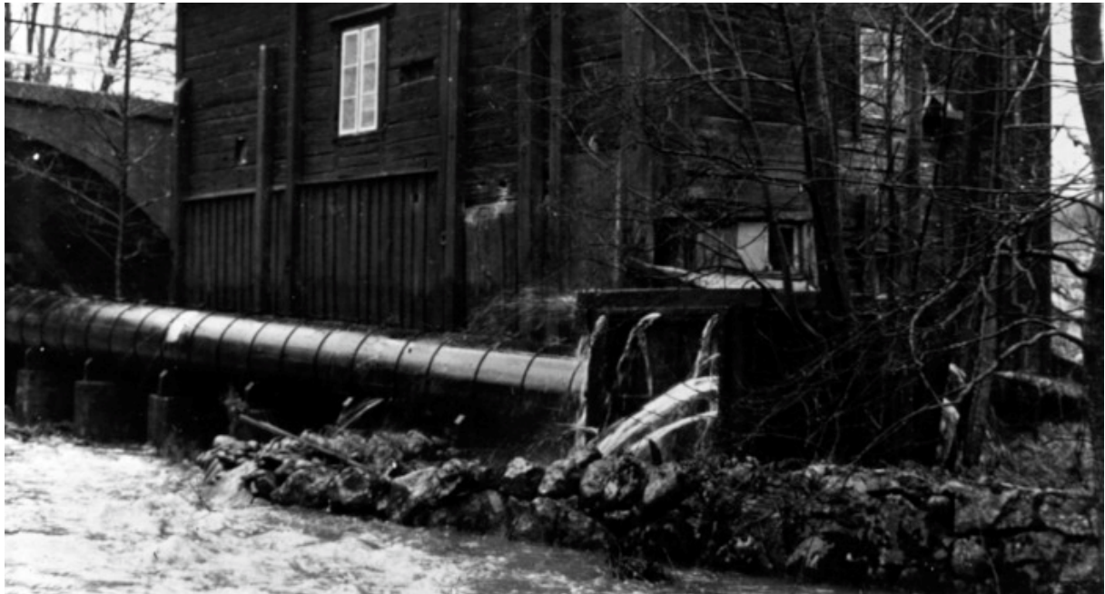
Bild 17. Kvarnen vid Järnadammen på 1950-talet, efter att rännan till kvarnhjulet ersatts av en trätub till en elturbin. Från Stockholms läns museums bildarkiv. Foto Per Andersson.
