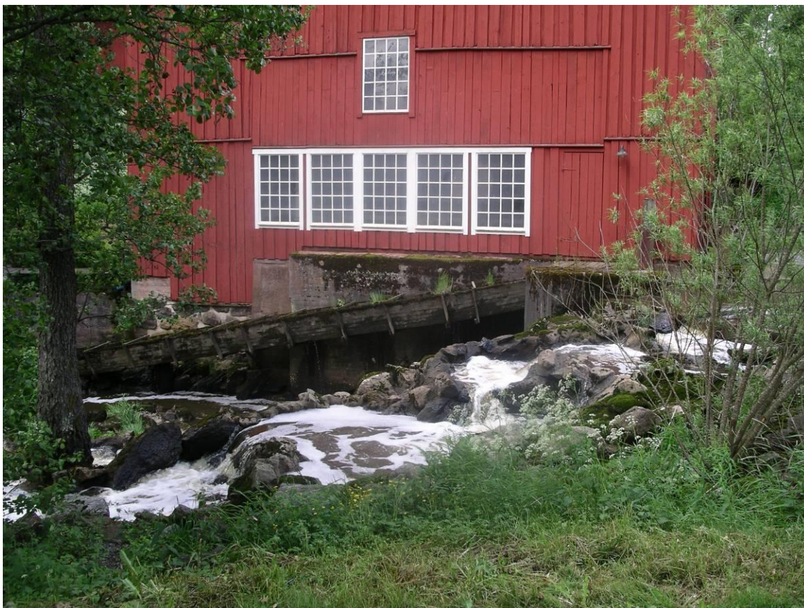
Figur 18. Exempel på fiskväg med natursten ingjuten i betong. Foto: Sverker Lovén.
