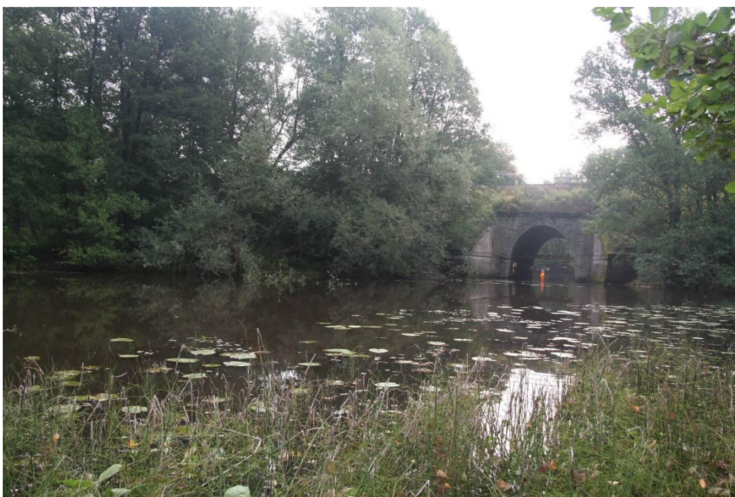
Figur 5. Den uppdämda delen av Moraån uppströms Järnadammen, mot järnvägsbron. Foto: Johan Kjellin.
