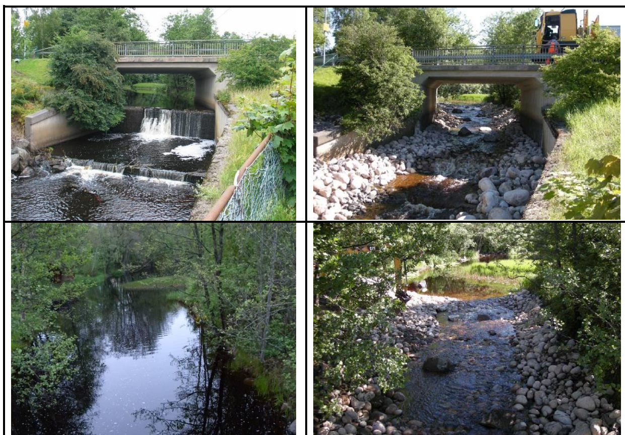
Figur 15. Exempel från liknande projekt med åtgärd av dammbyggnad. Bilderna visar före och efter åtgärd nedströms och uppströms dammbyggnaden, Imälven, Karlskoga 2010. Foton: Johan Kjellin till vänster och Martin Larsson till höger.
