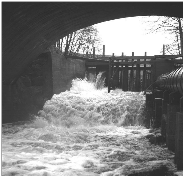
Den gamla spettmanövrerade luckdammen och en vattentub av trä som ersatt vattenrännan. Över forsen välver sig en valvbro av betong som 1939 ersatte den gamla dammbron. Bilden är tagen 1960 av Per Andersson. Foto Järna Hembygdsförening.
