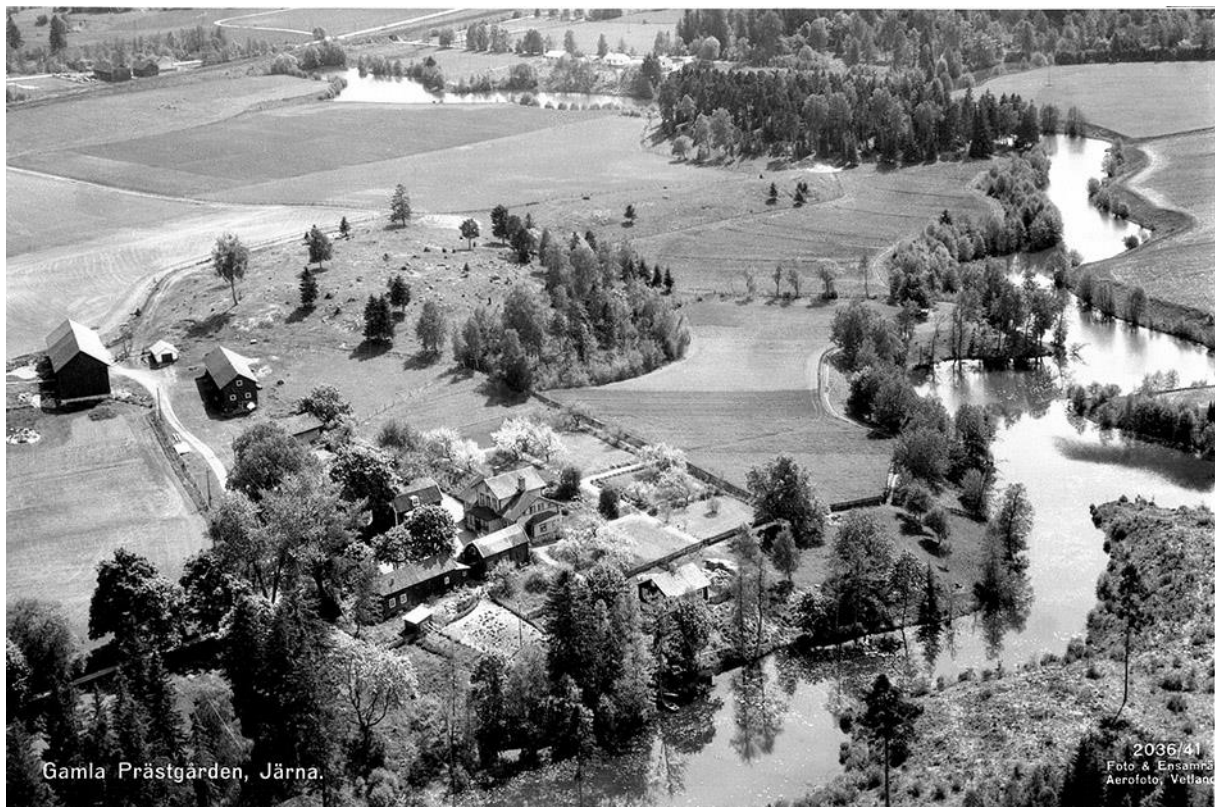
Tälleby prästgård och Nykvarnsdammen sommaren 1941. I övre vänstra hörnet ligger Nykvarn och väg 57. Dammens vattennivå var cirka en meter högre än vad det är i dag. Flygfoto AeroFoto, Vetlanda. Bild Järna Hembygdsförening.
