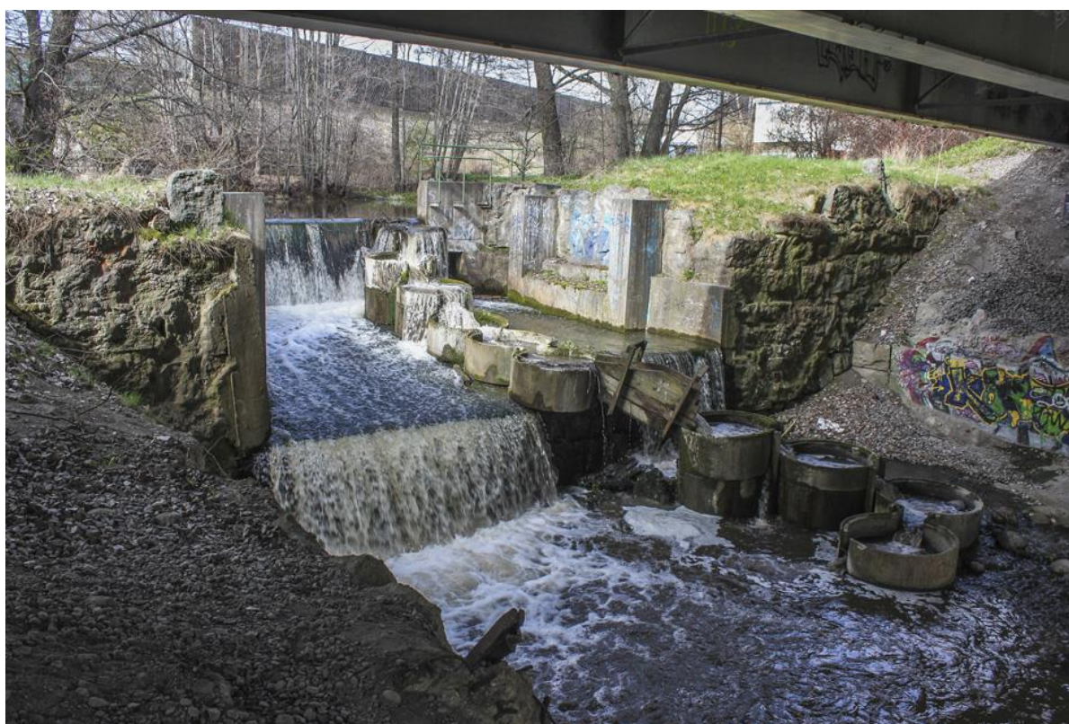
Nykvarnsdammen sedd från nedströmssidan med (från vänster till höger): landfäste, skibord, fisktrappa, bottenöppning samt på höger landfäste U-format betongstöd för provisoriska bron nr 3. Foto BS 2016.
