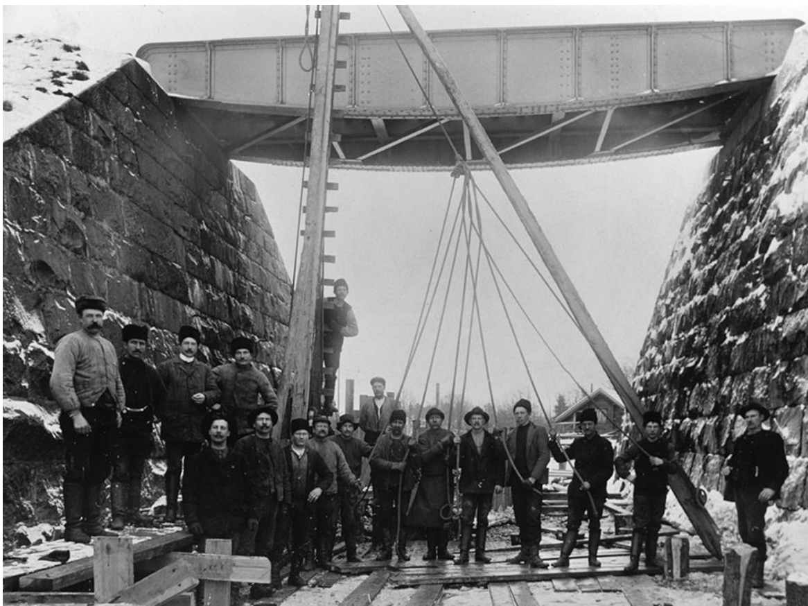
Brobygget med rallare 1909. Notera den gamla bron med nitad konstruktion. Foto Järna Hembygdsförening.
