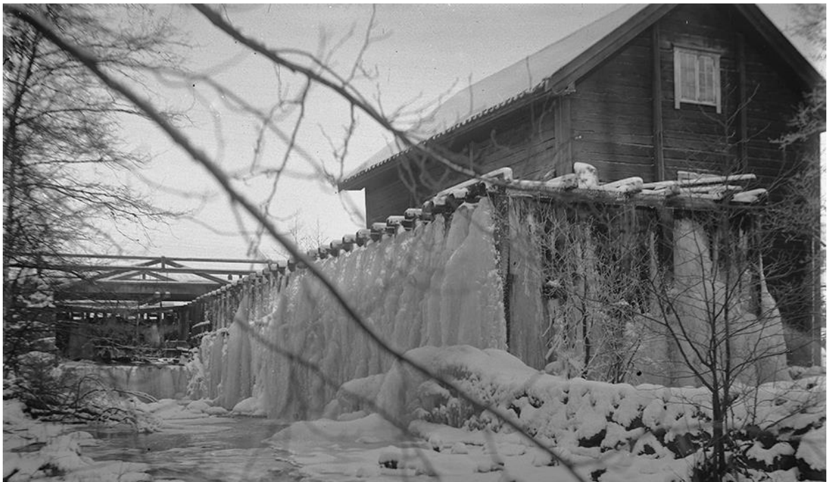
Nykvarns mjölkvarn på ett foto från 1910-talet. Den kombinerade dammen och vägbron av hängverkstyp från början av 1900-talet syns i bildens vänstra del, liksom vattenrännan till kvarnmaskineriet. Fotograf David Lindberg. Foto Järna Hembygdsförening.
