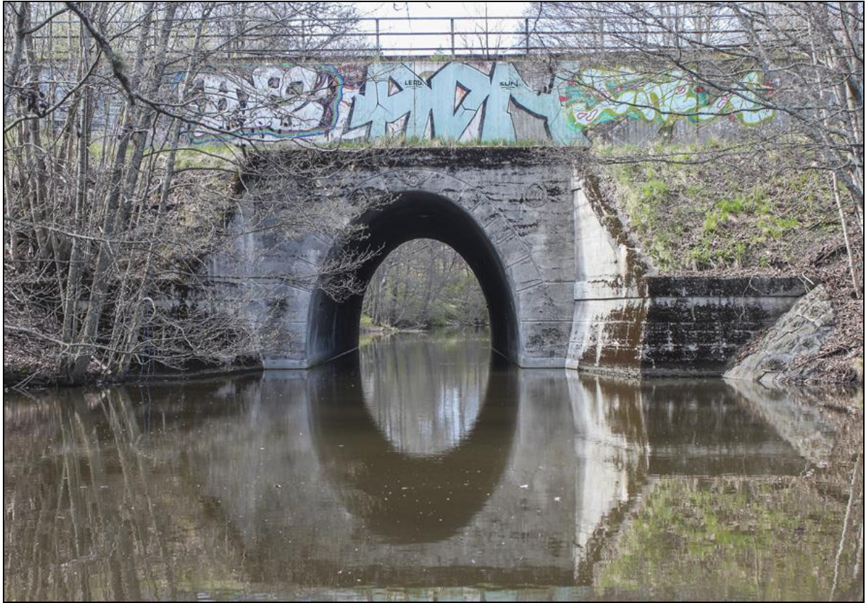
Järnvägsbron vid Järna sedd från nedströmssidan. Foto BS 2016.
