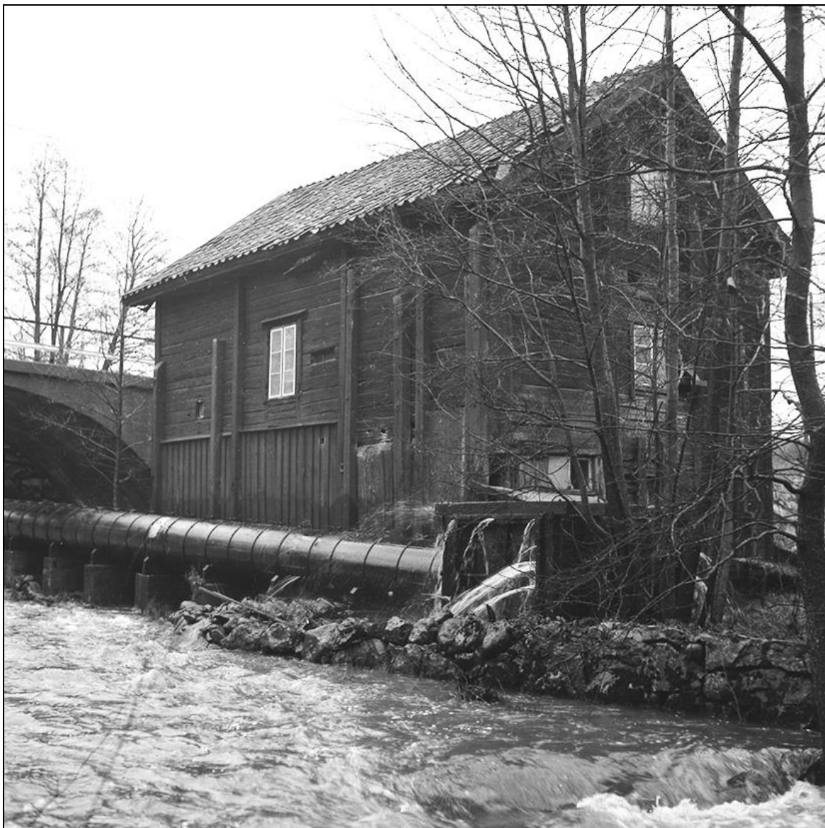
Kvarnen med vattentub och läckande trycksump för turbinen samt valvbron. Bilden är tagen 1960, året innan kvarndriften lades ner. Fotograf Per Andersson. Foto Järna Hembygdsförening.
