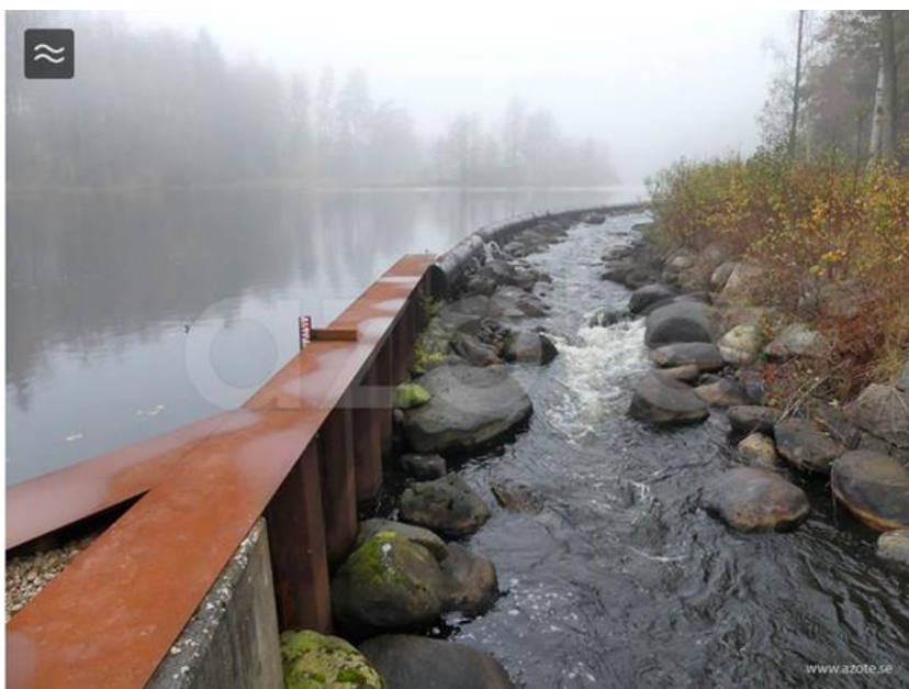
Figur 11. Exempel på inlöp med överströmningsbar spont vid Hemsjö, Mörrumsån.
