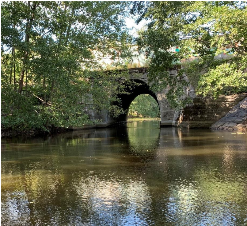
Figur 20. Järnvägsbron uppströms Järnadammen och vattenspegel (Foto: Sweco).
