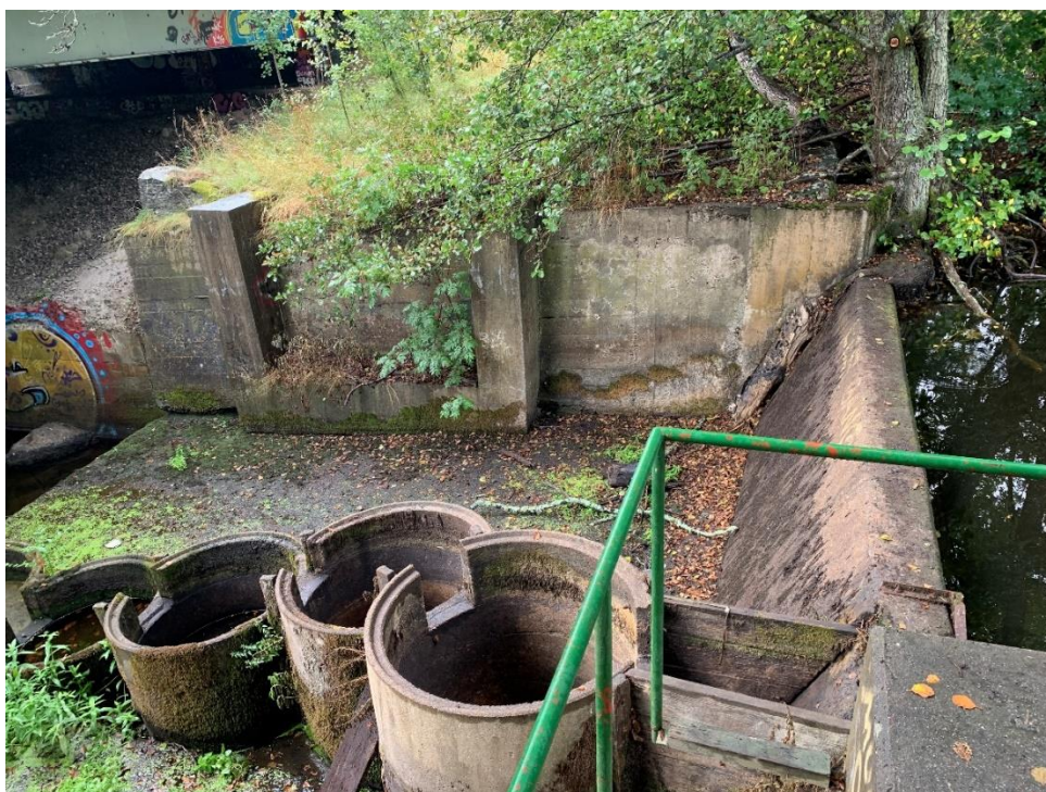
Figur 5. Befintlig damm. Foto: Sweco, 2020.
