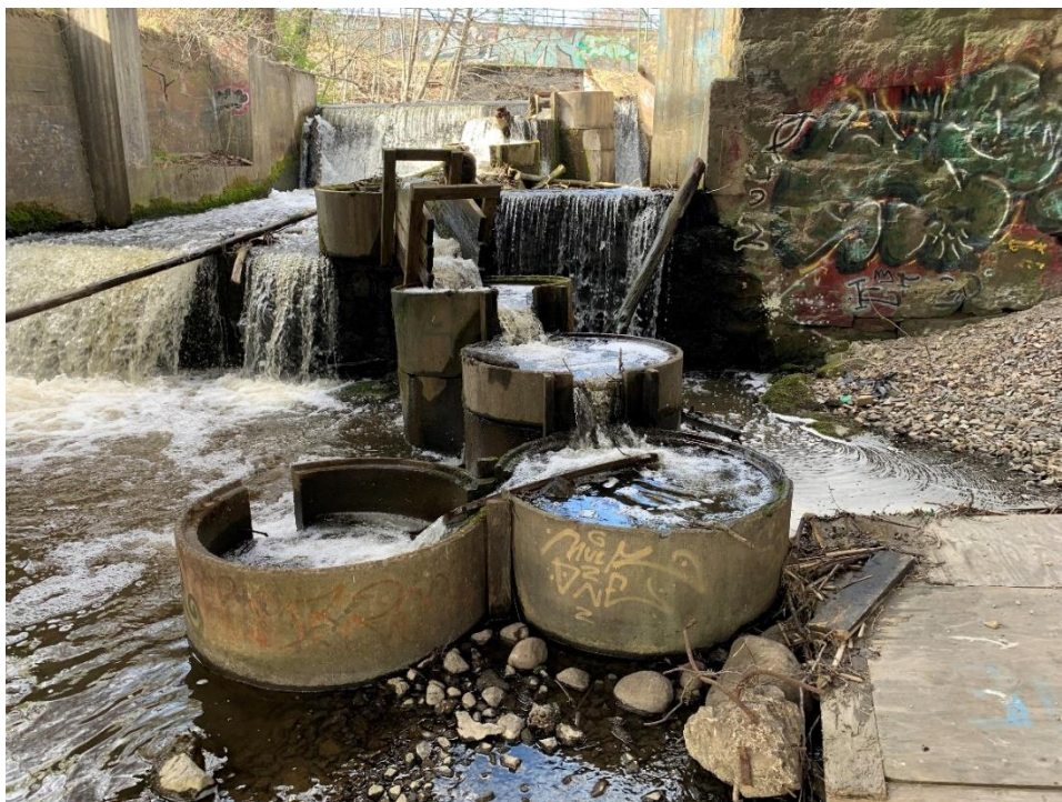
Figur 6. Järnadammen och befintlig fisktrappa. Foto: Sweco, 2020.
