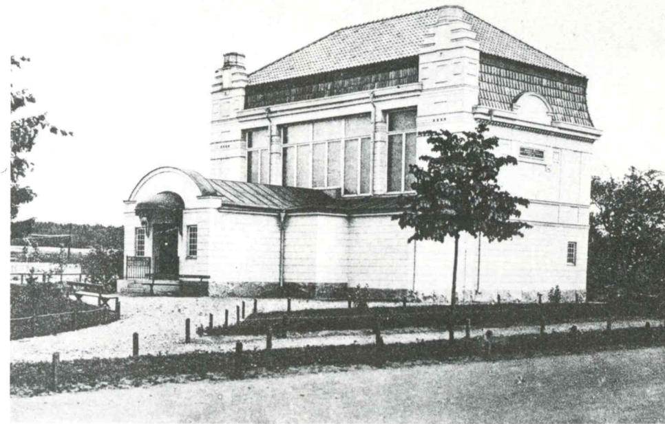
Södertälje Biologiska museum. Exteriör från öppningsåret 1913.
