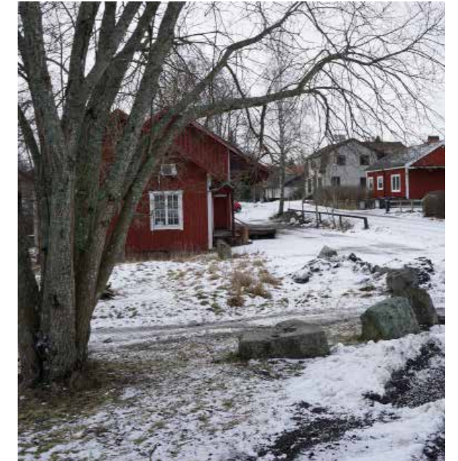
Godsmagasinet på Norra Järnvägsgatan.
