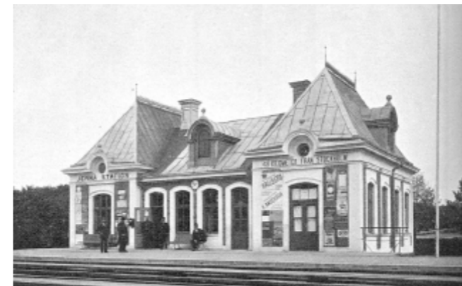
Järnas andra stationshus byggs. Denna gång på östra sidan av järnvägen.
