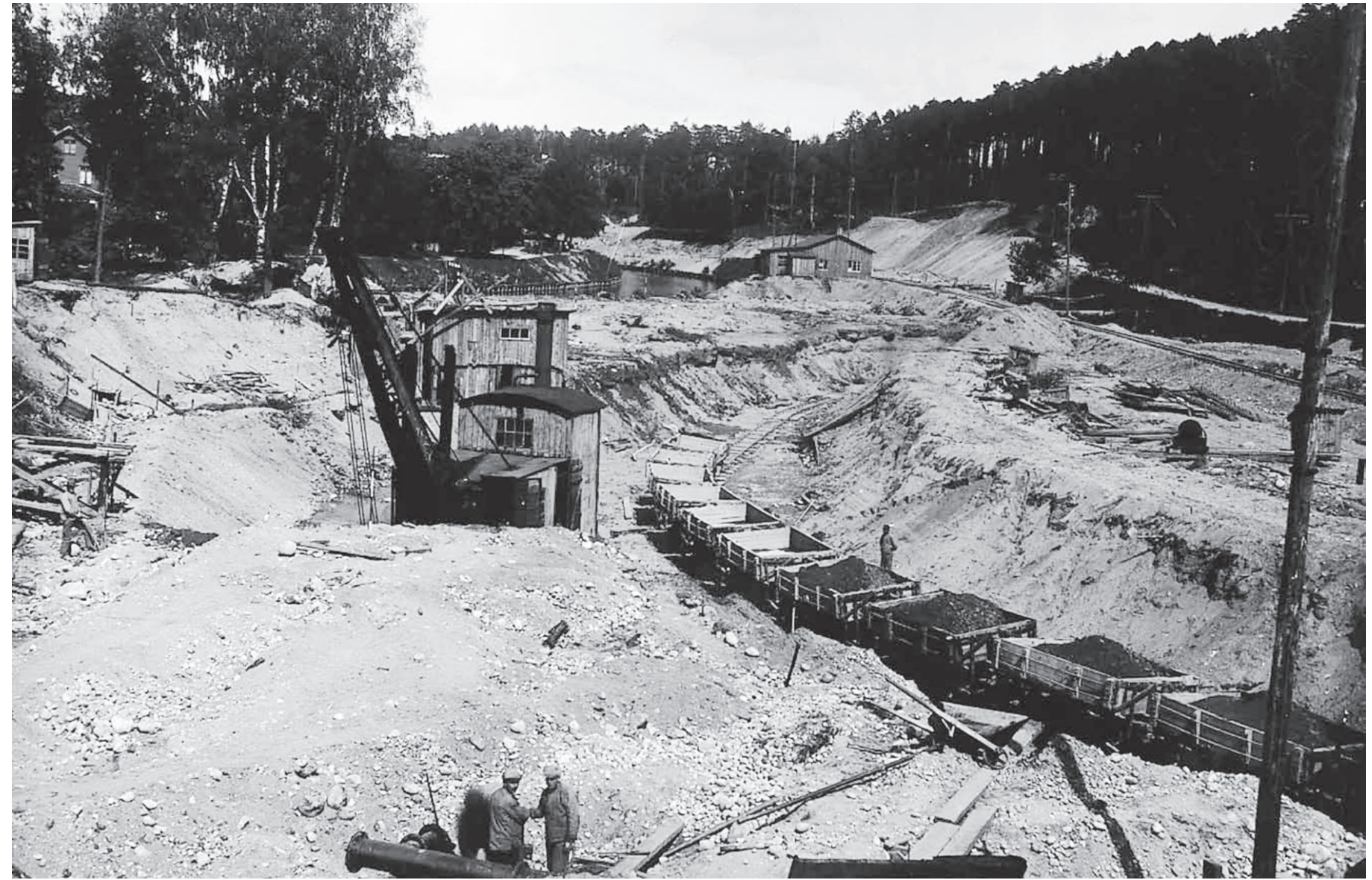
Schaktningsarbeten för den nya slussen sett från söder. Grävscooper i förgrunden var ångdriven och till höger om denna står vagnarna som körde rullstensgruset ut till Bergvik.
