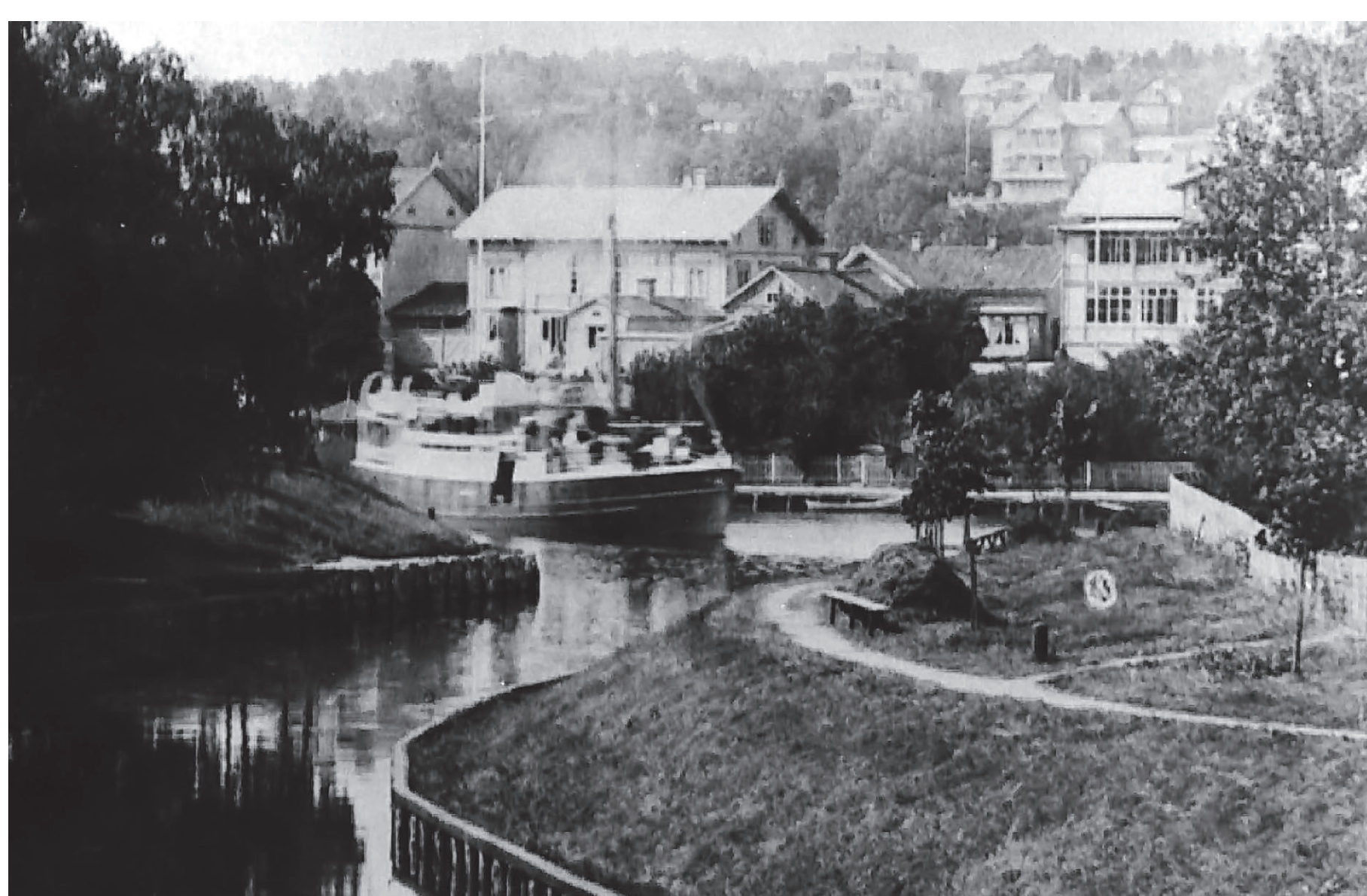
Ett fartyg girar från Inre Maren in i norra kanalen.
