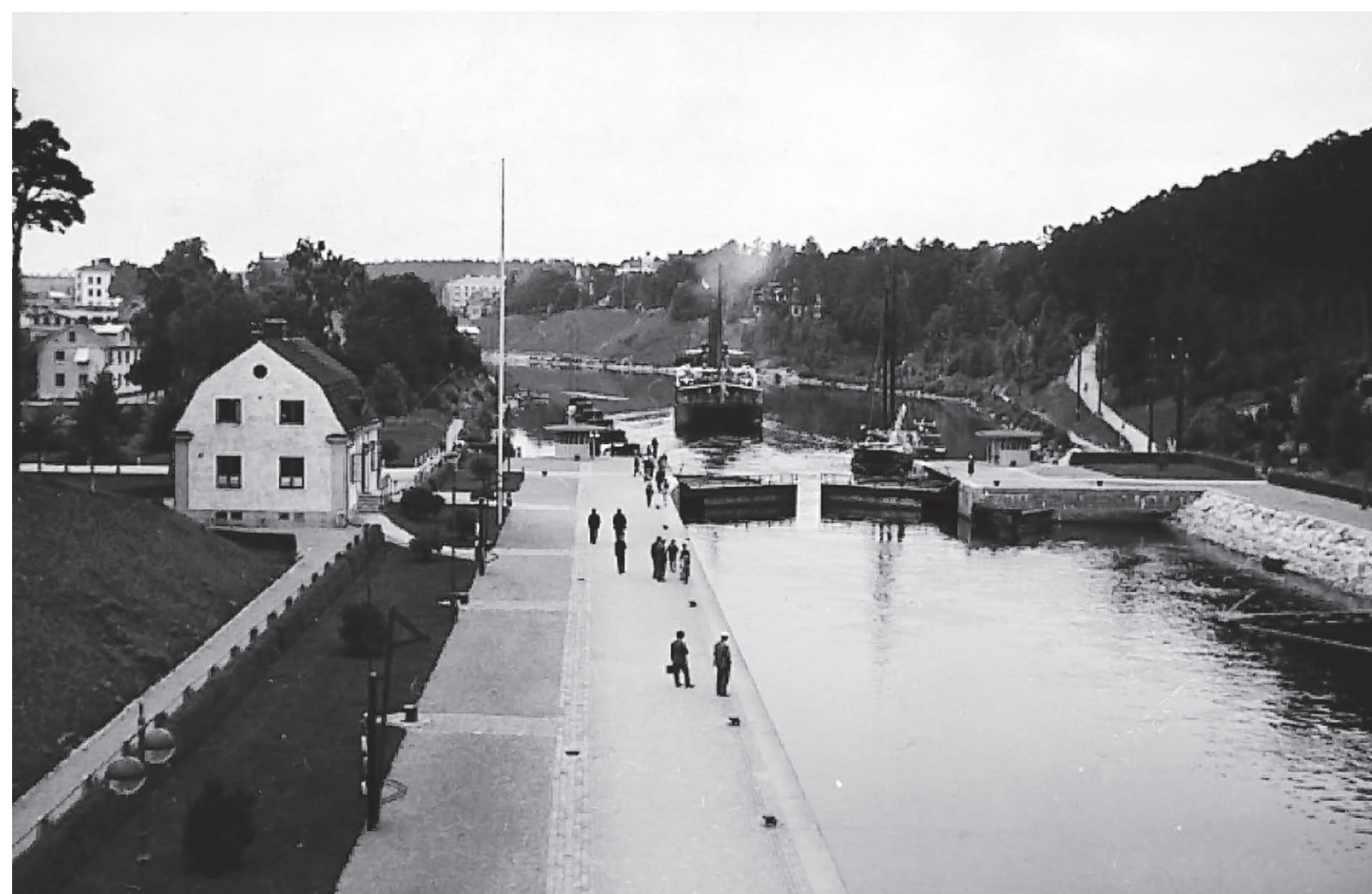
Nya Slussen, sedd från manövertornet, i slutet av 1920-talet.
