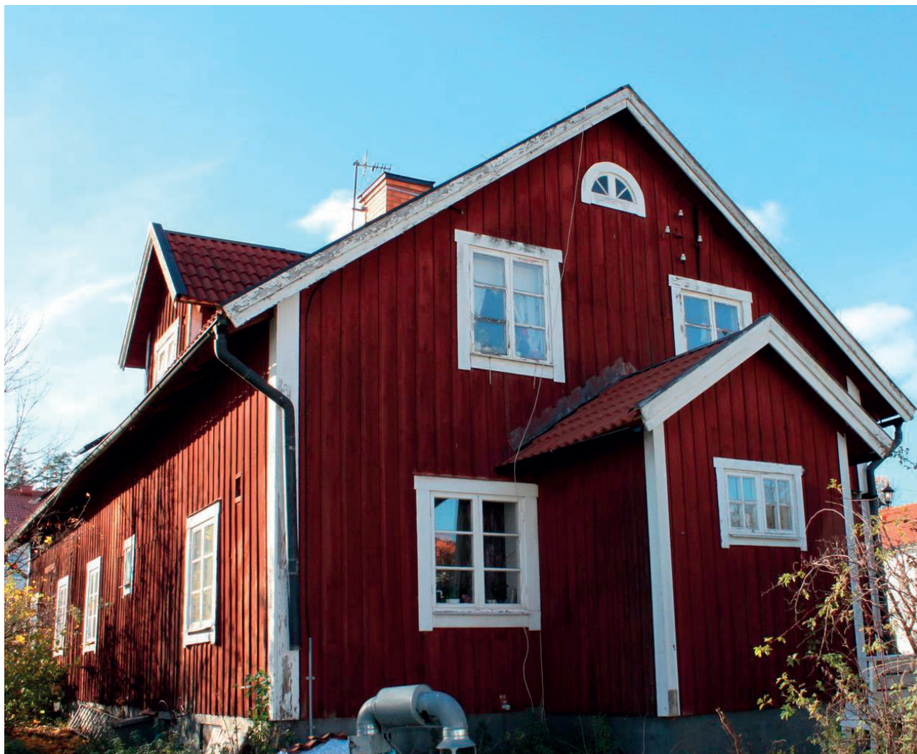
Huvudbyggnaden på fastigheten 1:8, kallad f.d. mejeriet, är troligen uppförd på 1920-talet.
