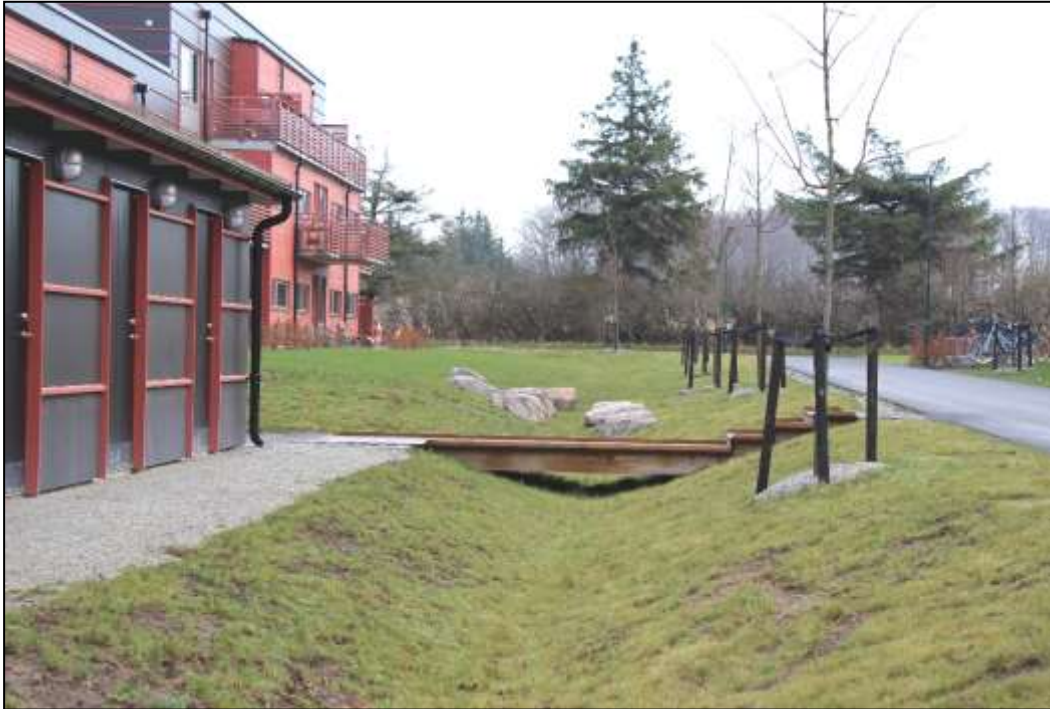
Figur 10. Exempel på svackdike i Gyllins trädgård, Malmö (Foto: Norconsult)
