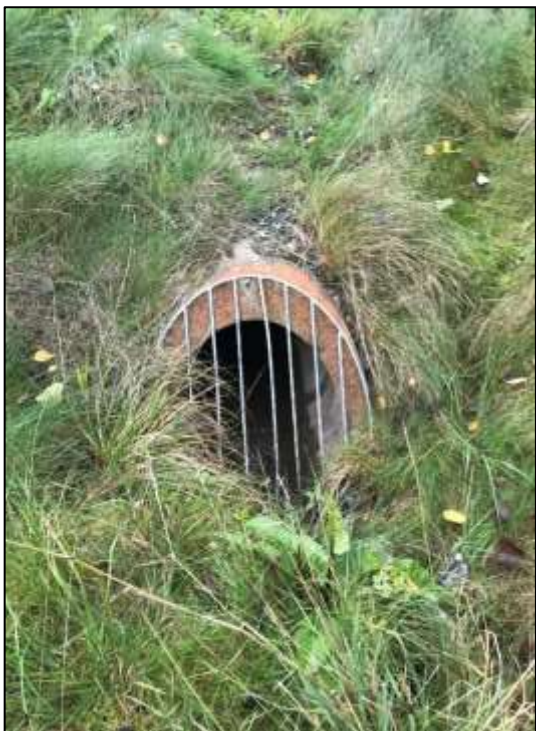
Figur 6. Gallerförsedd kulvert som leder vatten under Kaxbergsvägen, foto taget på södra sidan av Kaxbergsvägen.
