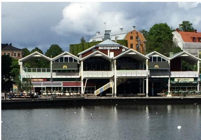
Bild 8: Vy mot befintlig byggnad
