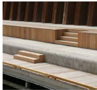
Kajkant i betong med inslag av trä
