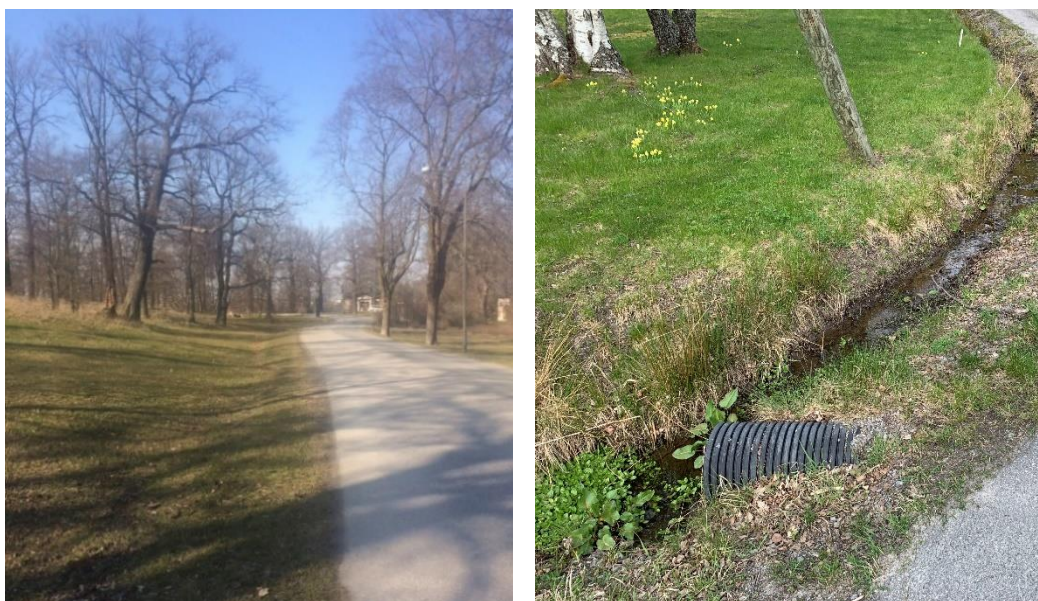
Figur 2. Exempelbilder svackdike och vägdike (foto: Bjerking)
