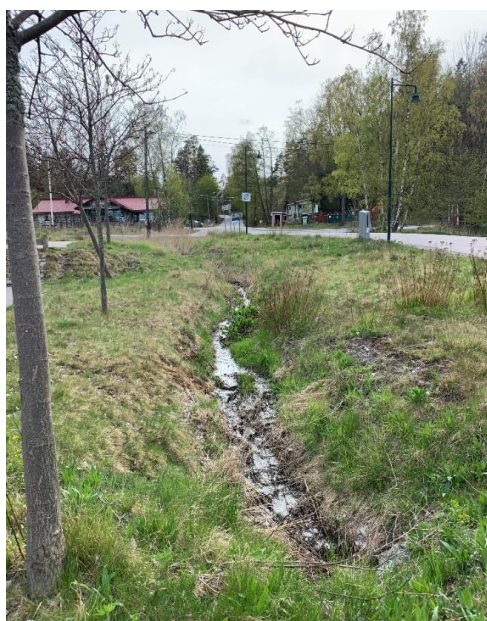
Figur 3. Lätt meandrande dike (Foto: Bjerking)
