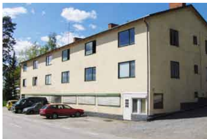
Flerbostadshus med verksamhet i bottenvåningen.
