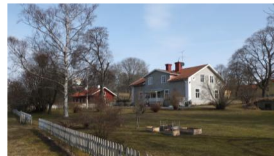
Statarbostaden som ursprungligen var bränneri.
