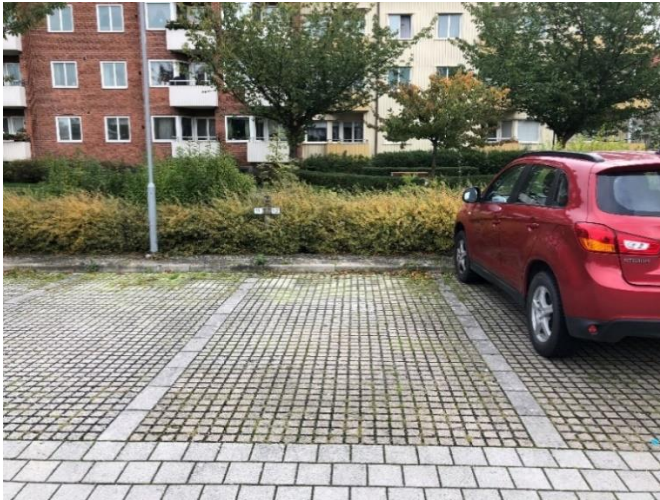
Figur 18. Exempel på genomsläpplig beläggning på parkering (foto Bjerking).
