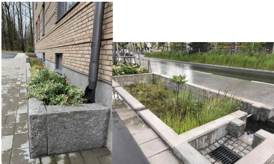
Figur 16. Exempel på upphöjd regnväxtbädd intill fasad respektive nedsänkt regnväxtbädd intill gcbana samt väg (foto Bjerking).
