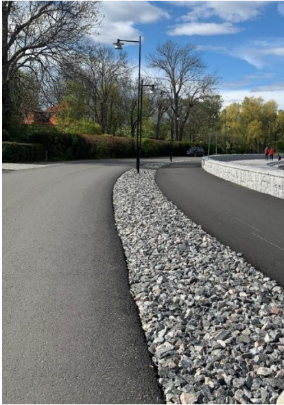
Figur 19. Exempel på makadamdike intill gc-bana och väg (foto Bjerking).
