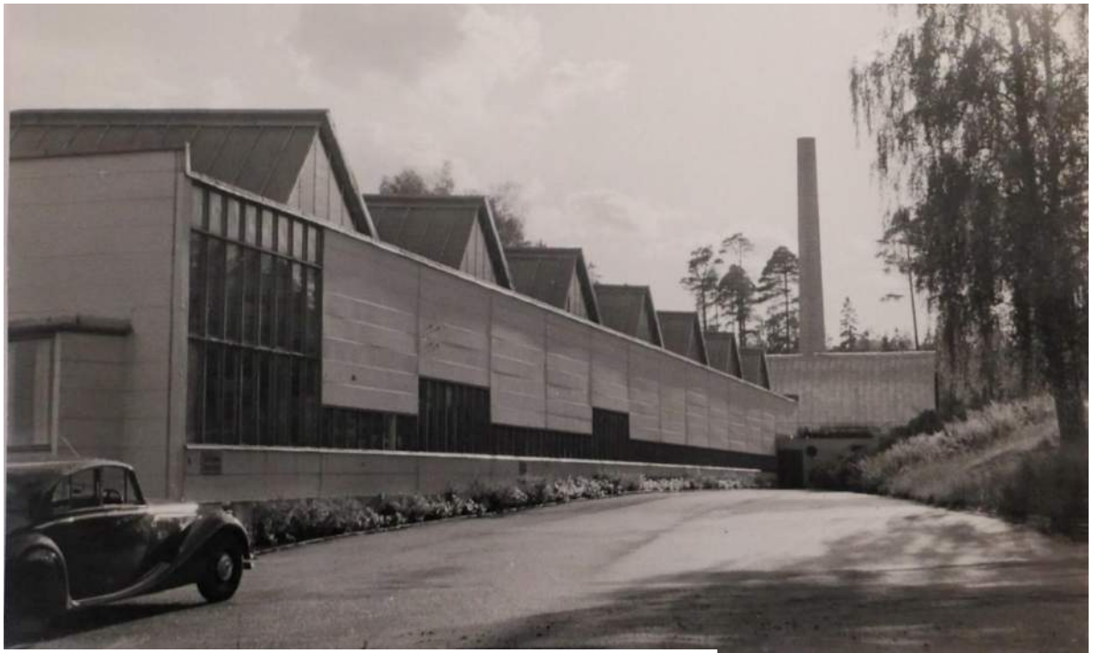
Bilmonteringshallen och panncentralen, nyligen uppförda. ArkDes.
