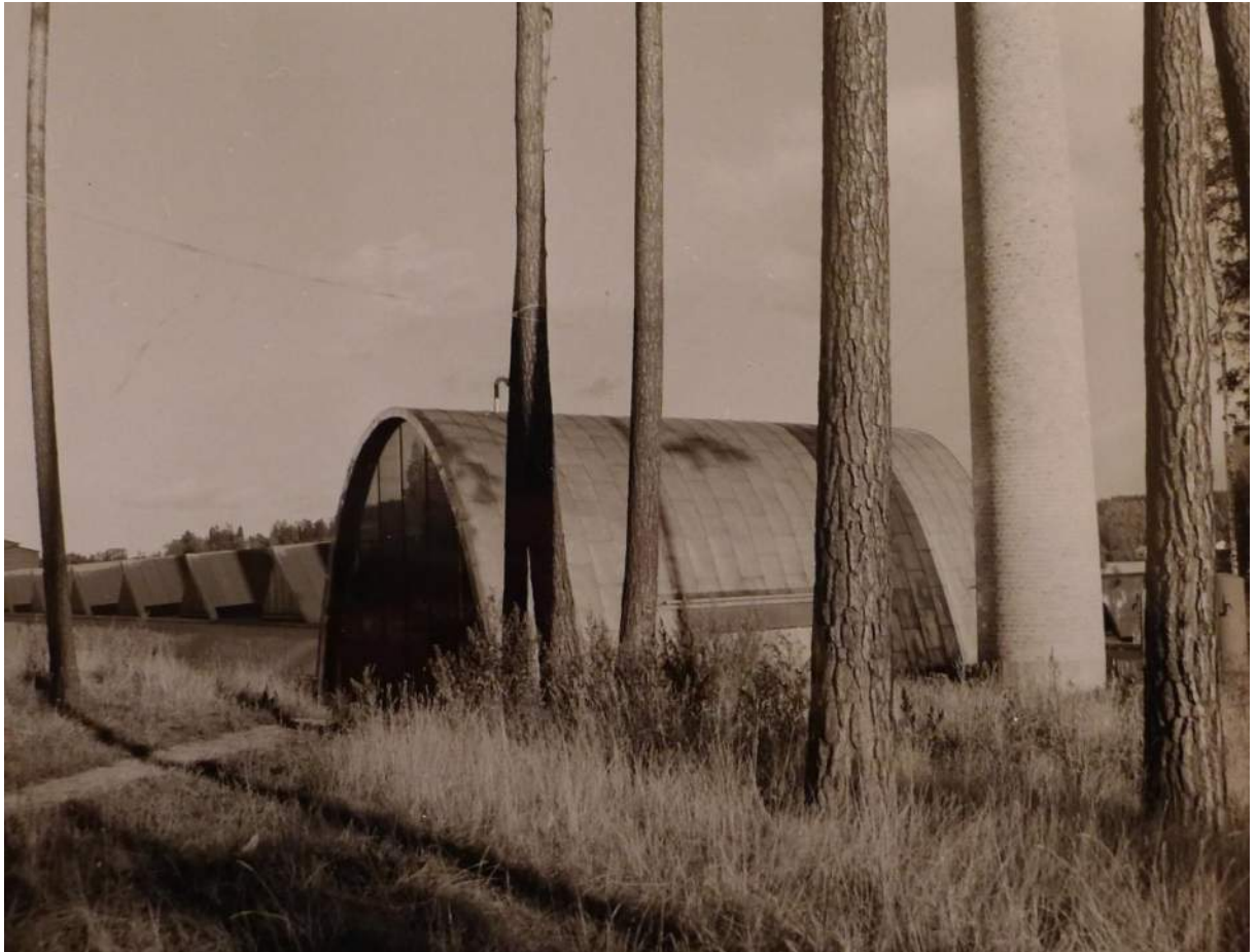
Byggnaden från nord-väst. Panncentralens höga skorsten samspelar tydligt med tallarna. ArkDes stammar.
