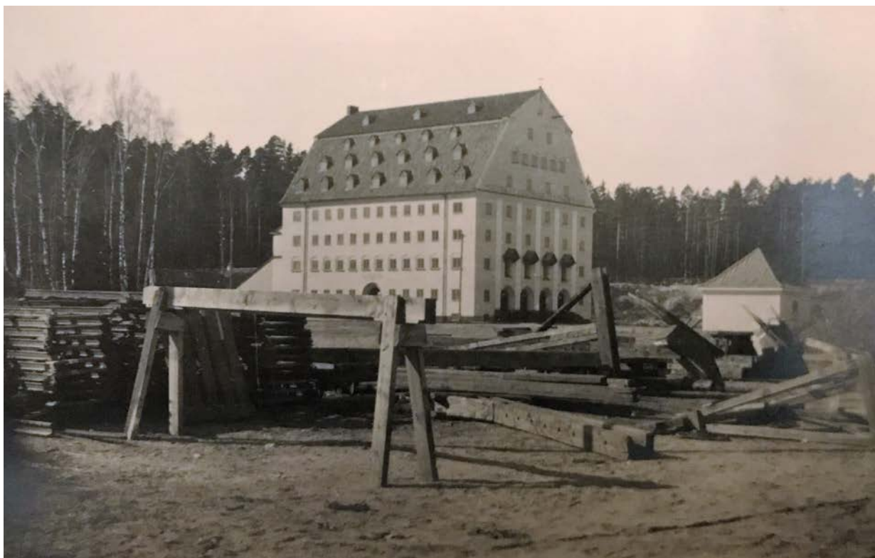
Fotografi som visar det nyuppförda hamnmagasinet, sannolikt snart efter att tillbyggnaden uppförts 1919. Bilden illustrerar hur området vid tiden till stor del inte var ianspråktaget, och förutom en mindre byggnad som här är okänd, är det obebyggt kring magasinet. Fotografi privat.
