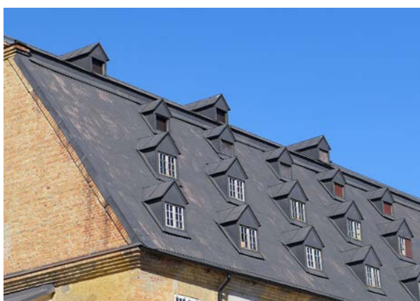
Byggnadens tak som idag är plåtklätt men sannolikt ursprungligen haft tegeltäckning.
