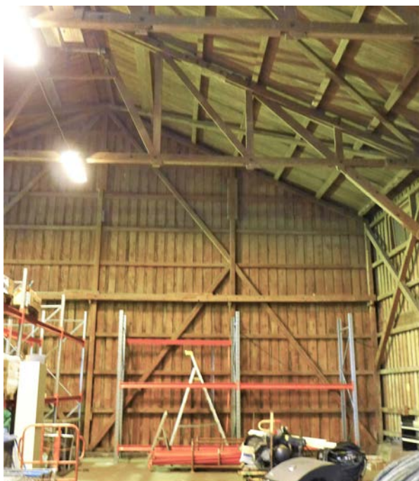
Trämagasinet som byggdes efter ritningar från 1938 står väster om tegelbyggnaden.
