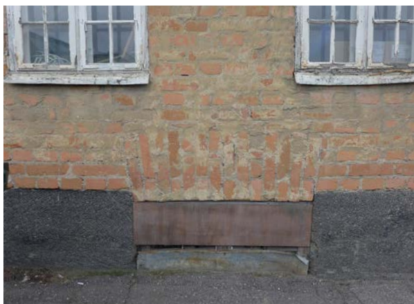
Tidigare källarfönster är idag igensatta.
