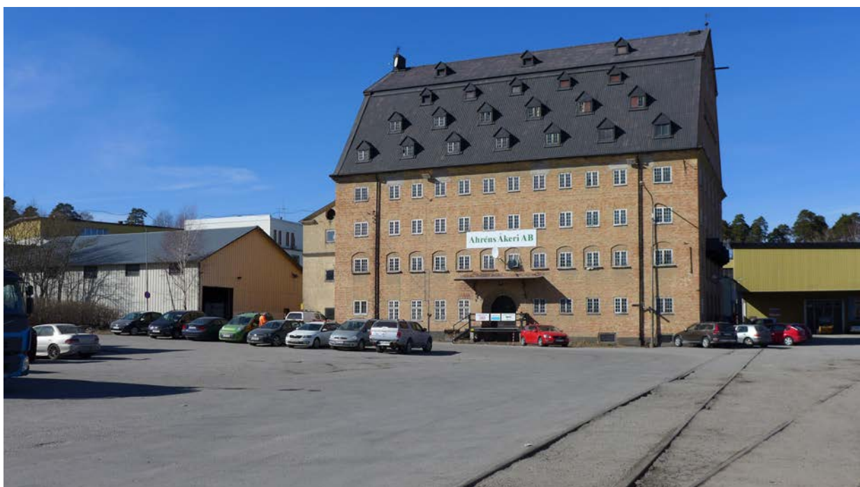
Översikt mot norr. Här ses hammagasinet och till vänster i bild trämagasinet.
