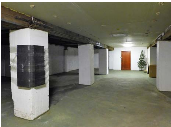
Källaren har samma pelarindelning som övriga byggnaden men har en stomme helt i betong.
