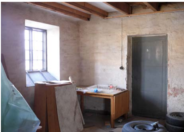
Våning 4 tr, med järndörr mot trapphuset.
