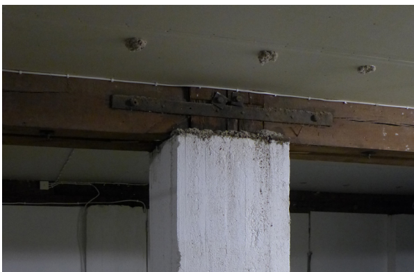
Detalj betongpelare och träbjälklag i källaren.
