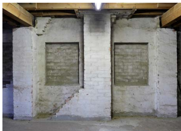
Murad vägg mot väster på våning 5 tr. Samtliga fönster på gaveln har murats igen men finns kvar som nischer både exteriört och interiört.
