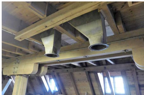
Trattar i taket på våning 4 tr, som tillhör de få bevarade spåren efter hanteringen av spannmål i byggnaden.
