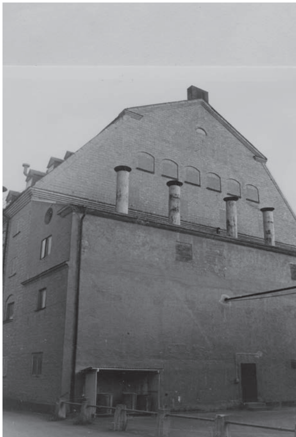
Fotografi från 1974 som visar tillbyggnaden från nordväst. Ur kulturhistorisk inventering. Idag är skorstenarna rivna.
