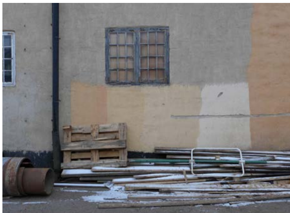
Nordfasaden med delvis putsade ytor.
