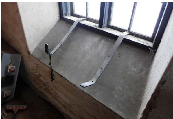
Gjuten fönsterbänk, ursprungliga enkelglasfönster och vädringsbeslag.
