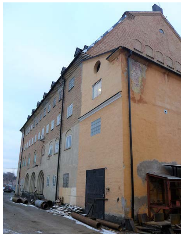
Översikt mot öster. Tillbyggnaden och delar av huvudbyggnadens nordfasad är putsade.
