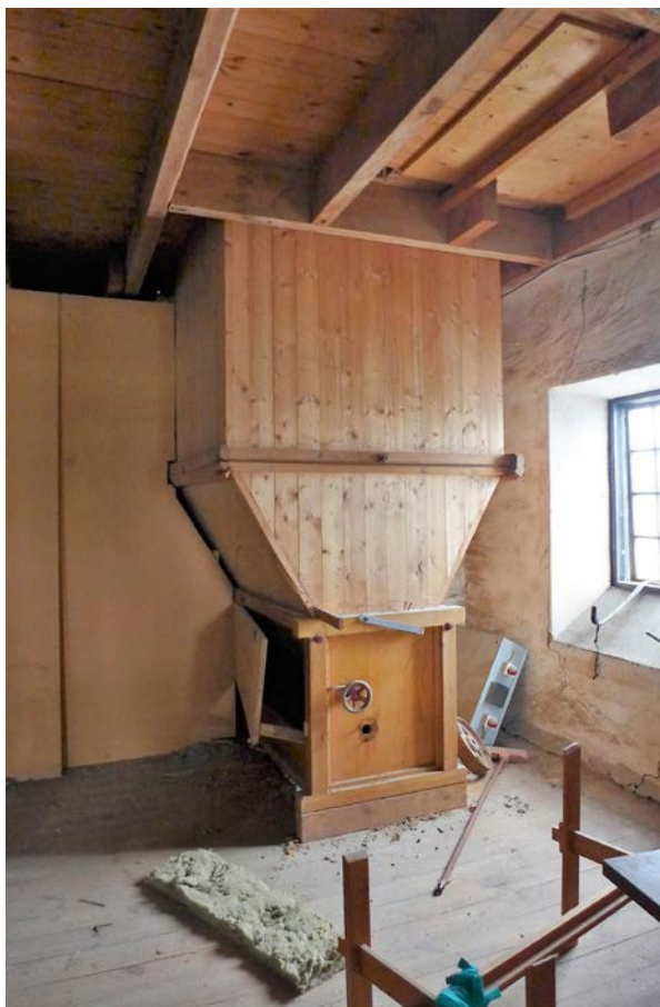
Invändig sädestransportör mellan våningarna.
