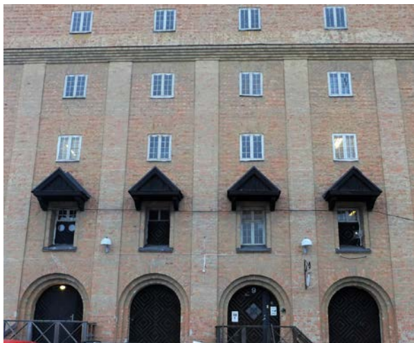
Östgaveln med ursprungliga fönster och portar samt karaktäristiska tak över första våningens luckor och fönster.
