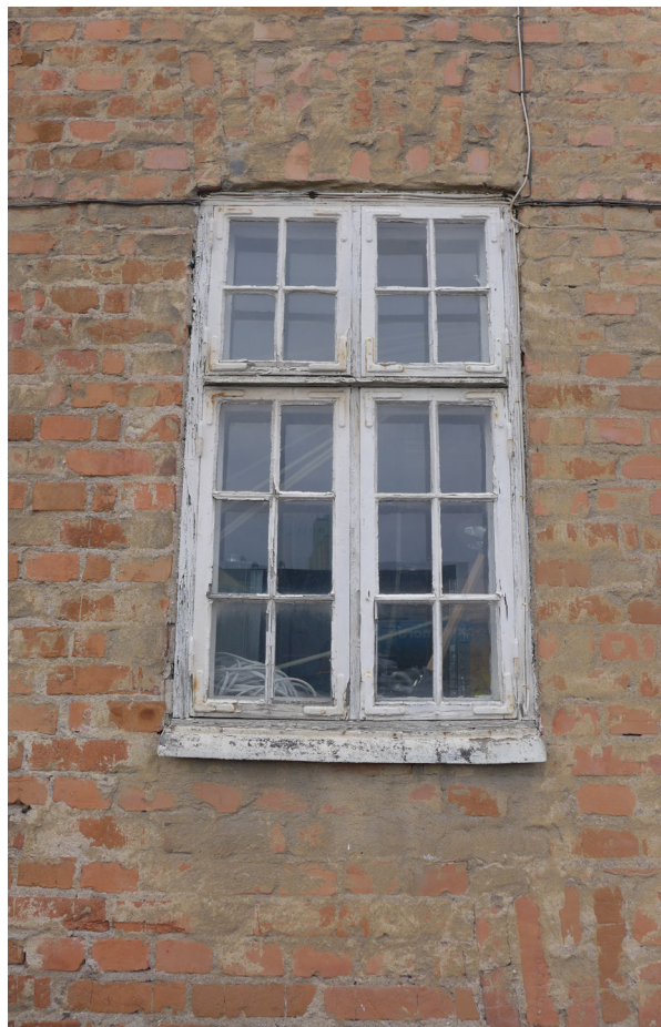
Byggnadens småspröjsade fönster är ursprungliga och i be
