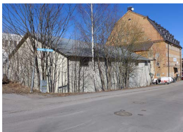
Trämagasinet som byggdes efter ritningar från 1938 står väster om tegelbyggnaden.
