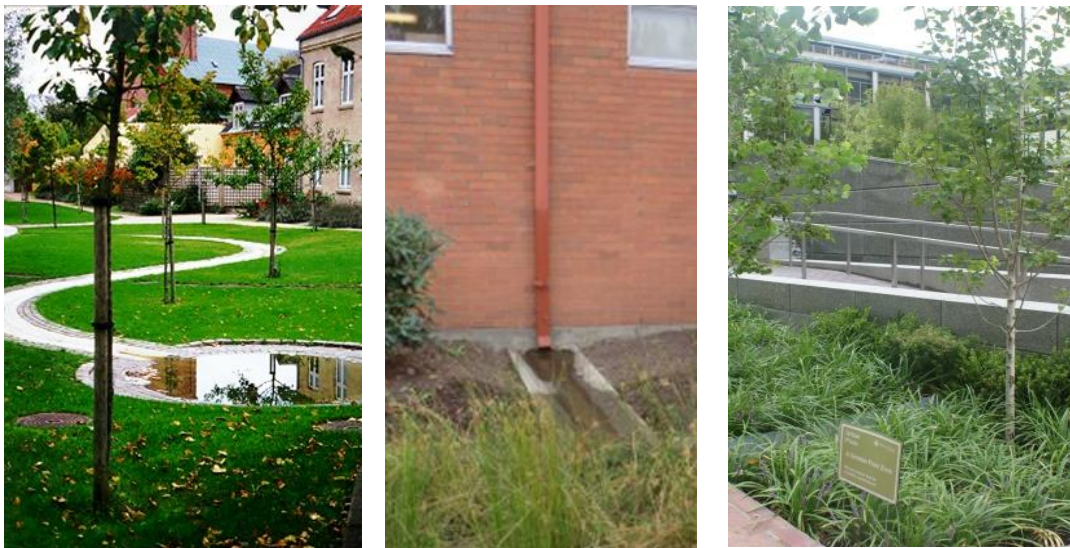
Figur 8. Exempel på dagvattenlösningar som lämpar sig på kvartersmark. Från vänster: en stenlagd översilningsyta som tillåts vattenfyllas vid regn, stuprörsutkastare med ränna som kan leda dagvatten till LOD-lösning, nedsänkt växtbädd för infiltration och fördröjning av dagvatten.
