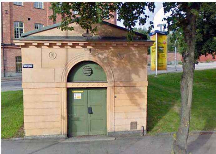
Foto: Transformatorstation i södra delen av planområdet.
