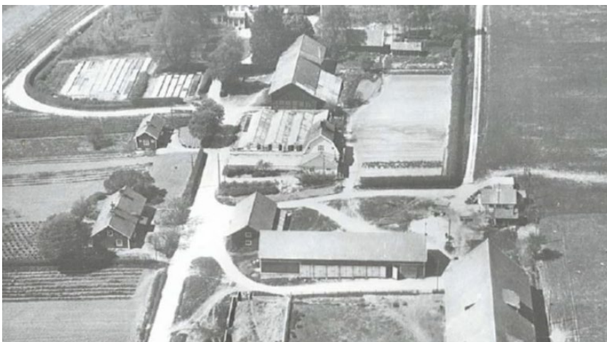
Bilden visar de gårdsbyggnader som tidigare fanns i anslutning till gården; häststallar trädgårdsmästarebostad, växthus och så vidare.
