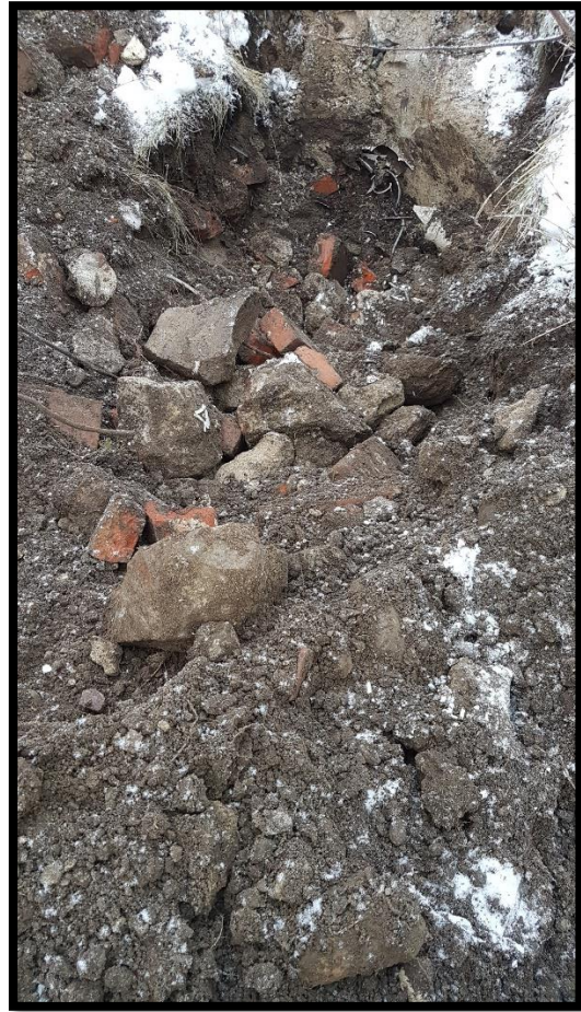
Figur 6. Provgrop 2; Rivningsmaterial, tegel, armeringsjärn m.m.
