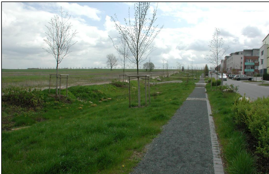
Figur 9. Exempel på utformning av svackdike. Foto: Norconsult
