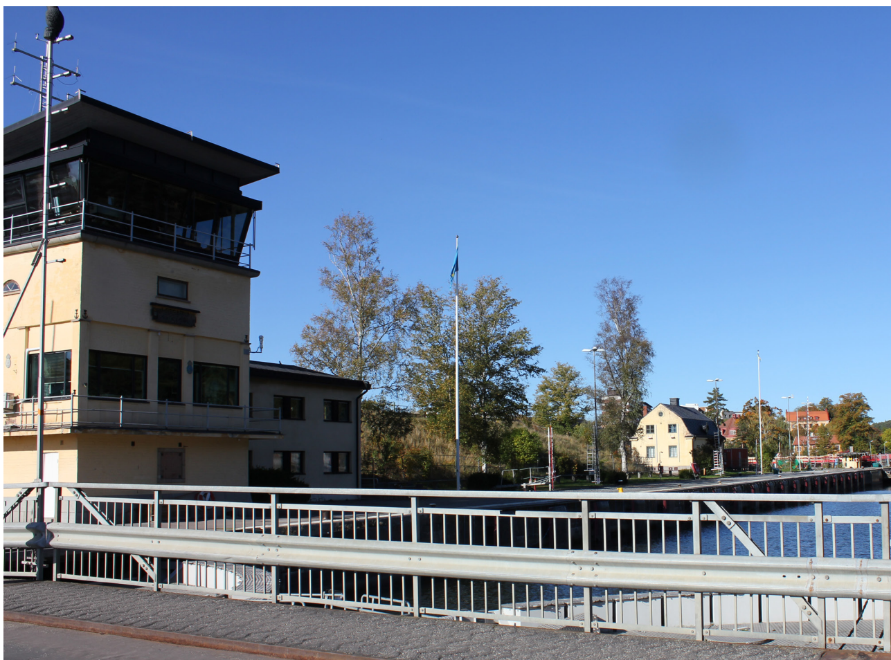
Bilden visar Manövertornet. I bakgrunden syns kanalmästarbostaden.
