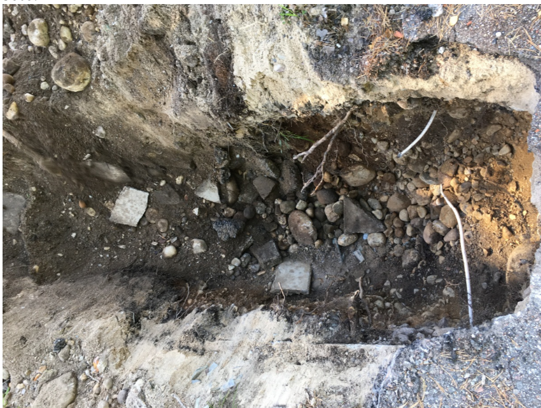
Foto 3. Fyllnadsmassor i provpunkt 5. Spår av stenplattor och tegel samt isälvsmaterial (rundade stenar, sand och grus).
