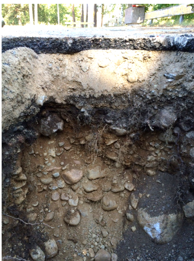
Foto 4. Jordprofil i punkt 5. Asfalt, nyare bärlager, äldre grusad yta samt isälvsmaterial.
