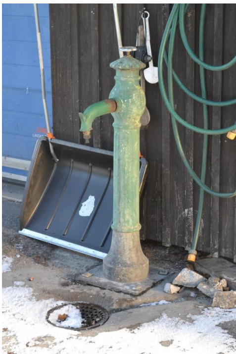
Pump intill den västra byggnadens östra fasad.
