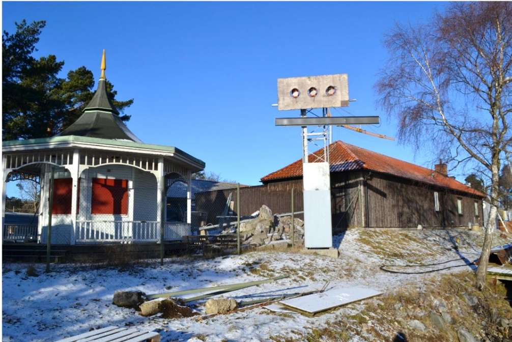
Verkstadsbyggnaderna sedda från sydöst, med östra huset i bakgrunden och paviljongen för tidigare caféverksamhet (främst under 1990-talet) i förgrunden.
