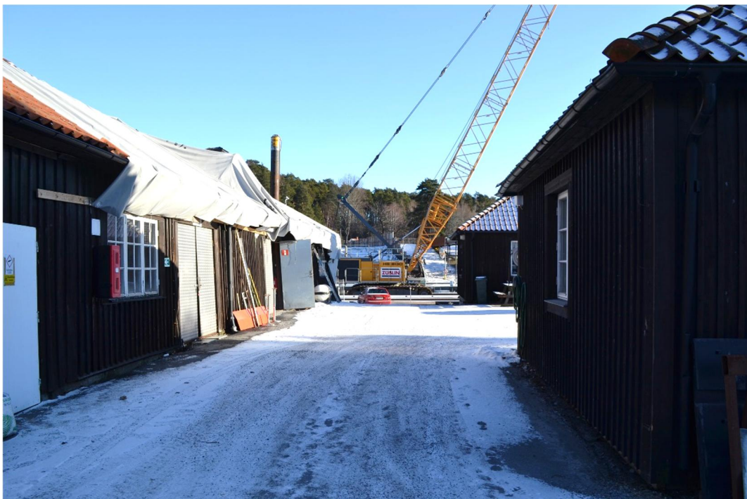
Den norra byggnadens södra fasad och den västra byggnadens gavel (till höger i bild).
