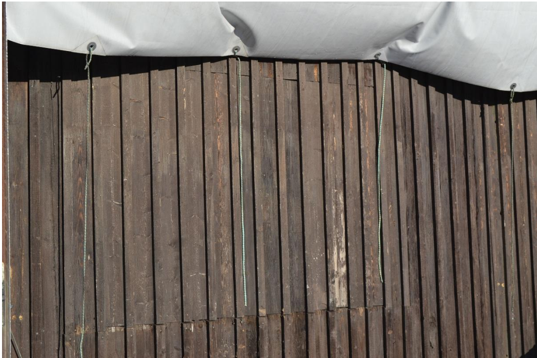
Placeringen för ett tidigare äldre fönster, nu igensatt med panel.
