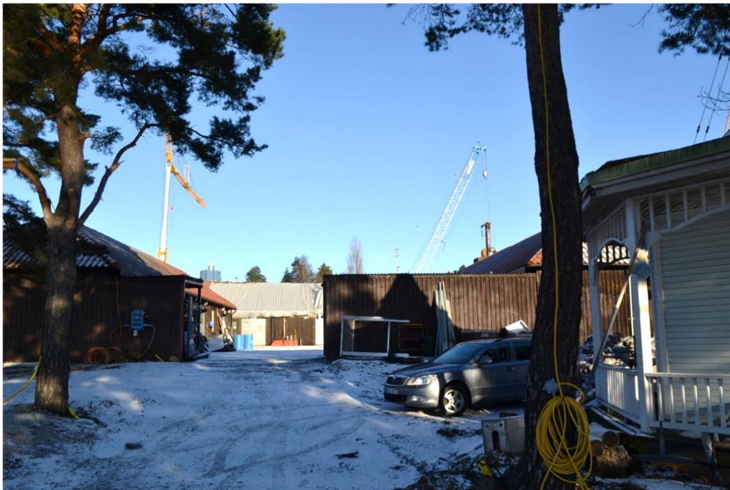
Byggnaderna och gården sedd från söder, med det södra planket mellan västra och östra byggnaden i förgrunden.
