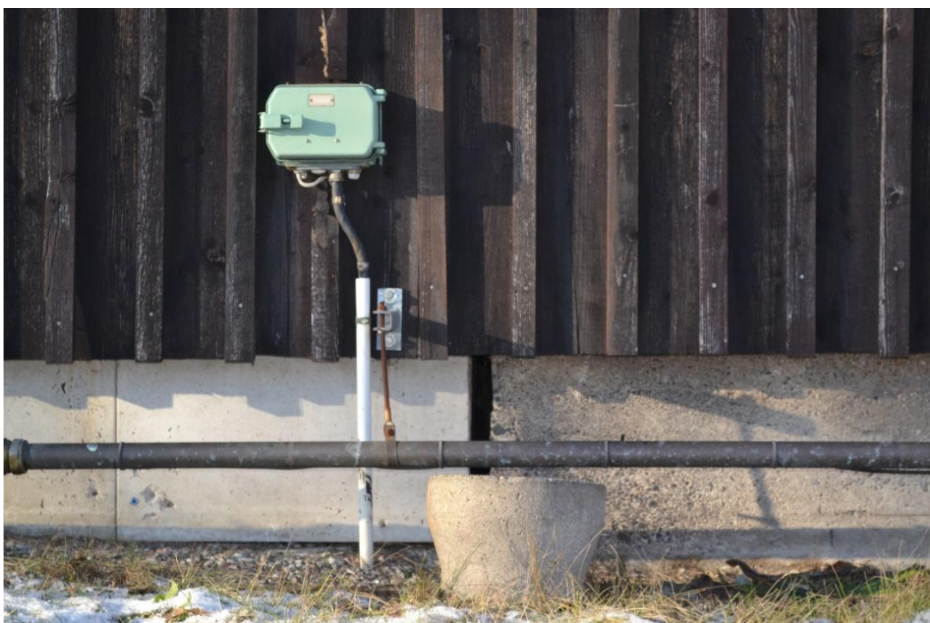
De äldre delarna av byggnaderna har en platsgjuten grund och sockel (till höger i bild) medan tillbyggnaderna har en sockel av obehandlade betongelement (till vänster i bild).
