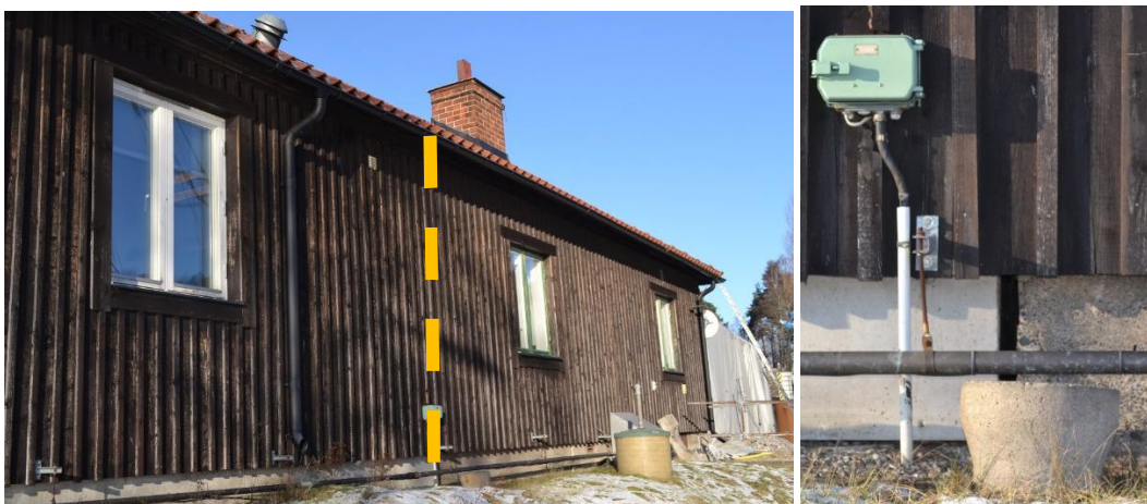
Östra byggnaden, östra fasaden. På den östrabyggnadens östra fasad syns att den södra delen av byggnaden är tillbyggd då sockeln inte är platsgjuten, som på den äldre delen av byggnaden, utan uppförd av obehandlade betongelement. Den gula markeringen markerar för storleken på den äldre byggnaden, som ursprungligen hade en centrerad skorsten. På den östra fasaden syns också två äldre fönster från 1940-talet (till höger om strecket) målade i en ljusgrön kulör och ett nyare fönster (till vänster om det gula strecket).
