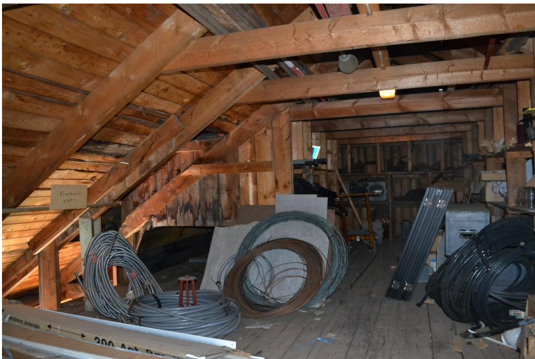
Vinden med takstol på den norra byggnaden.
