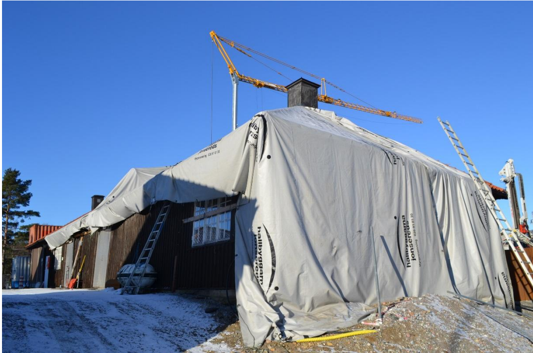
Den norra byggnadens östra gavel och södra fasad.
