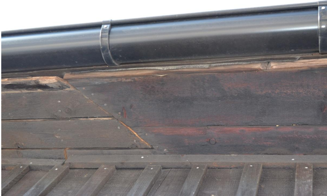
Inklädd takfot på den östra byggnaden.
