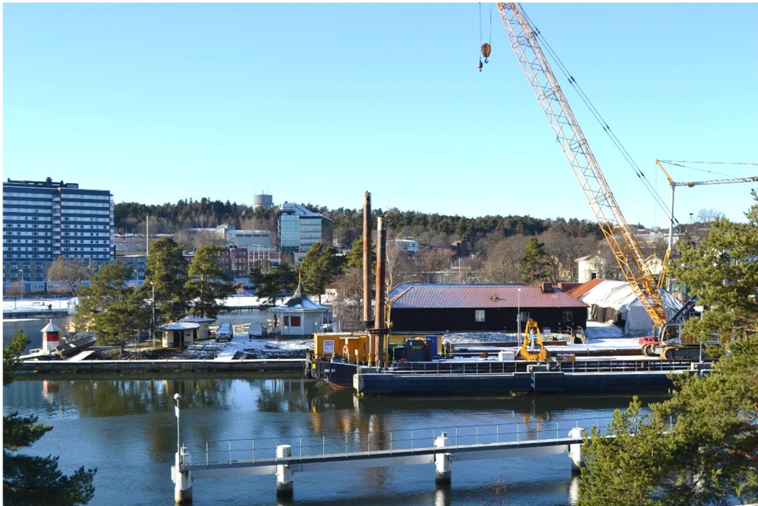
Verkstadsbyggnaderna sedda från öst.
