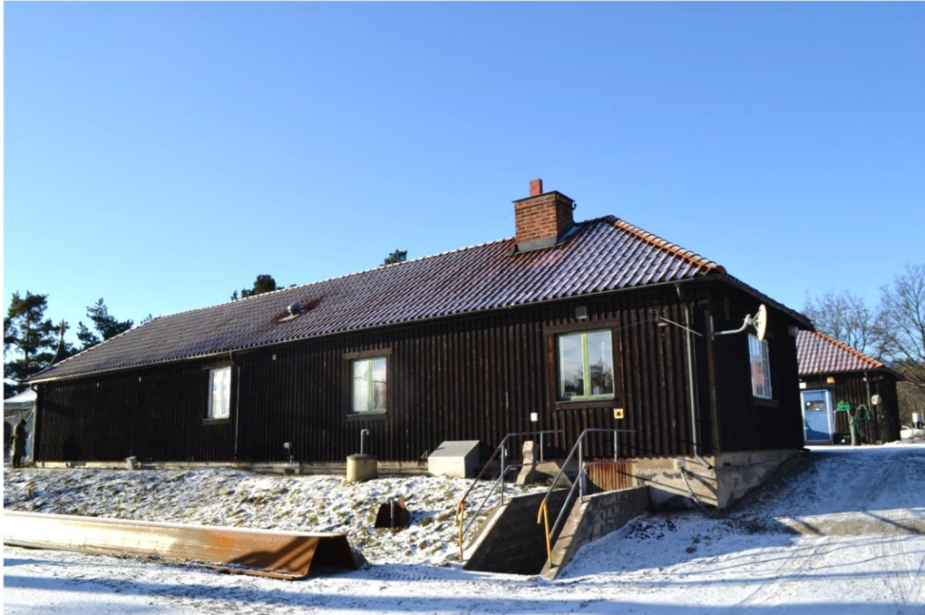
Den östra byggnadens östra fasad med ingång till källaren. Notera att det bara finns en murad skorsten, placerad på den äldre byggnadsdelen.
