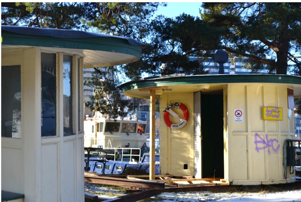
Tidigare överbyggnader till nedgångar till slussmotorerna, då placerade längs med slusskanalen.
