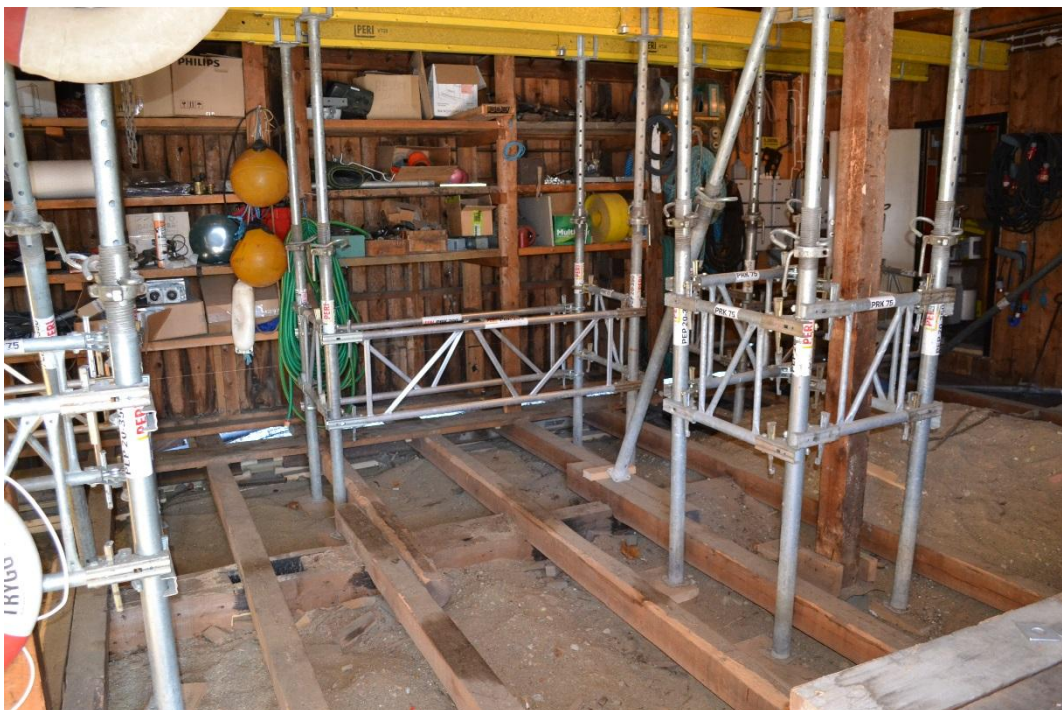
Förstärkning av den norra byggnaden invändigt då byggnaden satt sig i samband med byggandet av bron.
