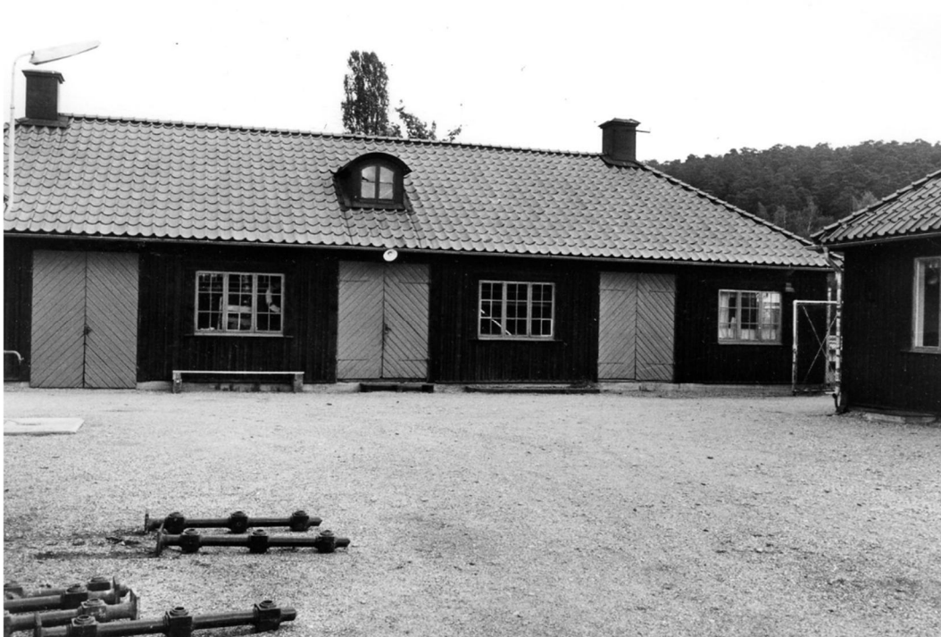
Inventeringen av bebyggelsen på Lotsudden, 1970-tal, norra byggnaden. På 1970-talet fanns flera äldre fönster bevarade på den norra byggnaden. Utav de tre på bilden finns endast ett kvar, det till höger i bild, med spår i fasadens träpanel där de tidigare två andra fönstren suttit. Skorstenarna är placerade symmetriskt i valmningens topp och i linje med de flankerande byggnadernas gårdsfasader.
