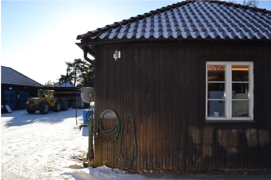
Den västra byggnadens norra gavel.
