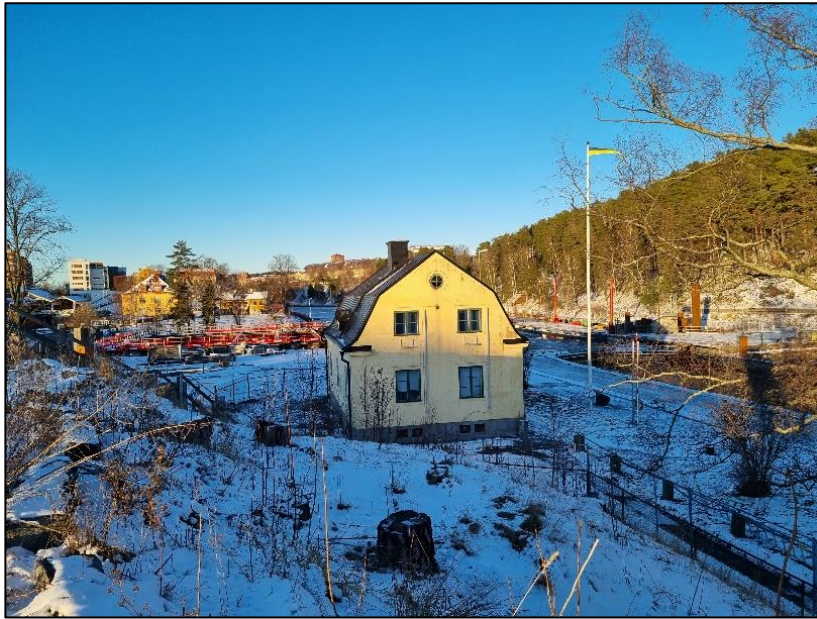
Figur 4:1. Byggnad sett ifrån höjden på Slussholmen. Foto: Norconsult 2022-01-21
