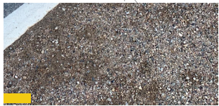
GC-bana: harts-/cementbundet grus på asfalt, Y1b
