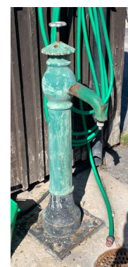
Pump på innergården
