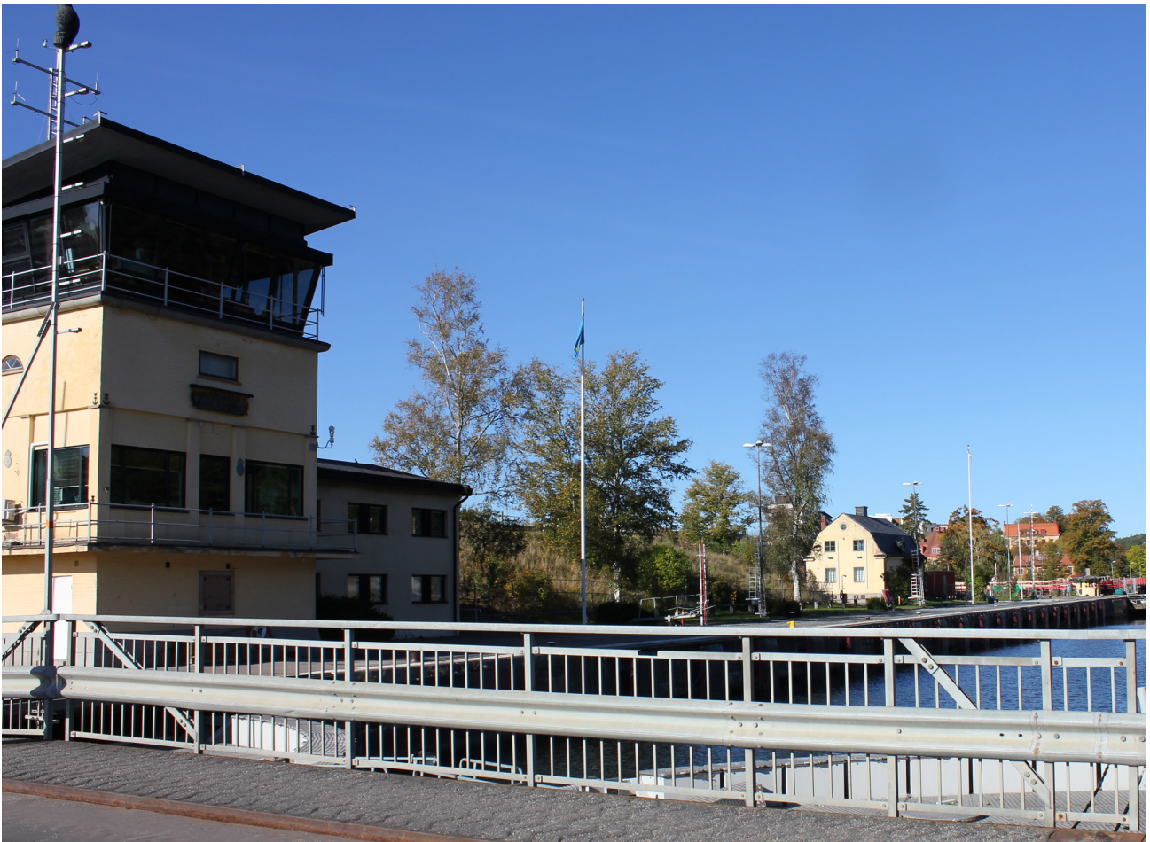
Bilden visar Manövertornet. I bakgrunden syns kanalmästarbostaden.
