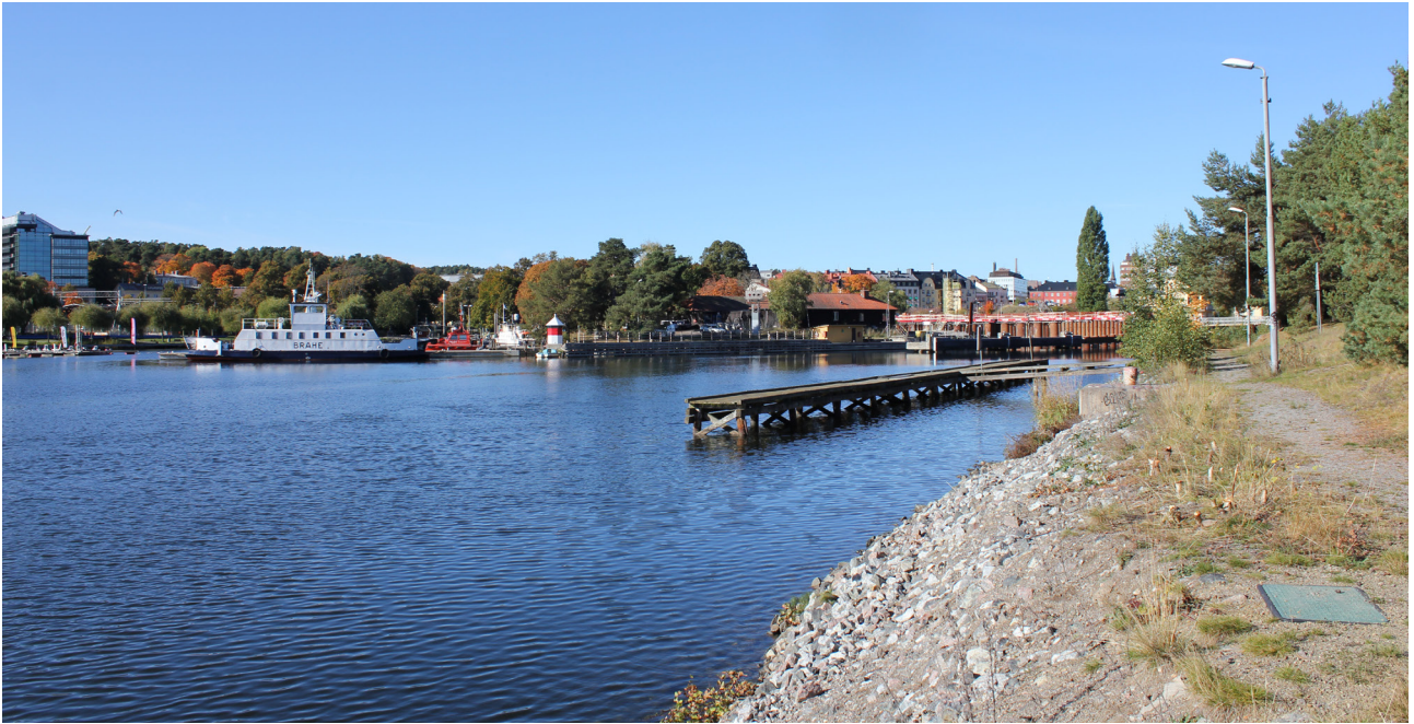
Bilden visar befintligt kanalstråk (grusvägen till höger i bild) söder om den befintliga slussbron.
