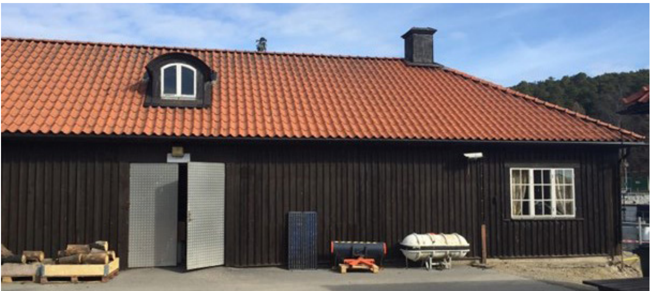
Bilden visar byggnad C. Befintlig fasad, innan rivningen. Vy mot norr. Bild av Södertälje kommun.
