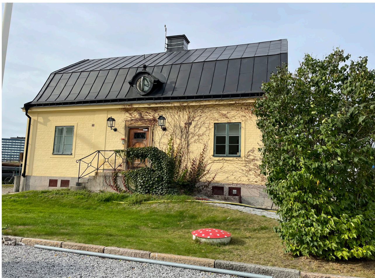
Bilden visar Kanalmästarbostaden. Bilden är tagen i västlig riktning. Foto av Södertälje kommun, september 2023.
