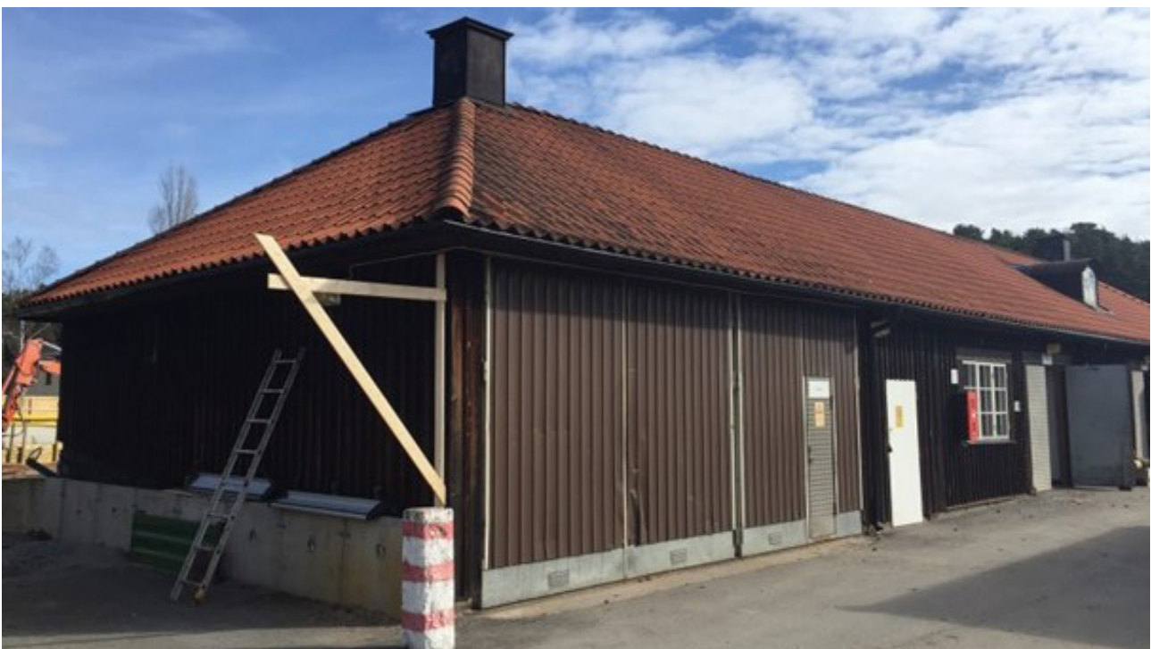
Bilden visar byggnad C. Befintlig fasad, innan rivningen. Vy mot nordöst. Bild av Södertälje kommun.
