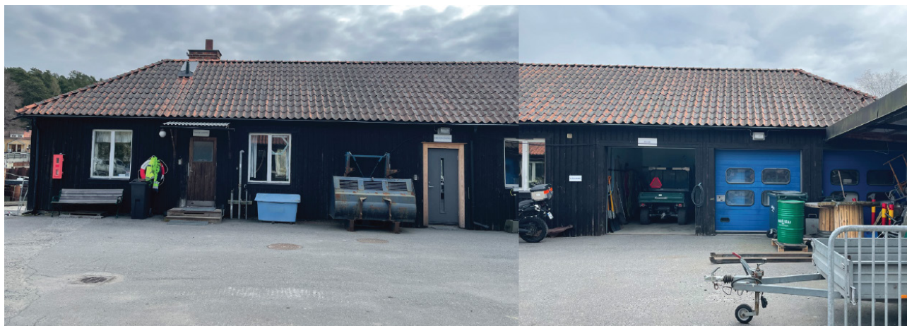
Bilden visar byggnad B. Befintlig fasad mot verkstadsgården i väster. Bilder från Restaurangutredningen, framtagen av Nyréns.
