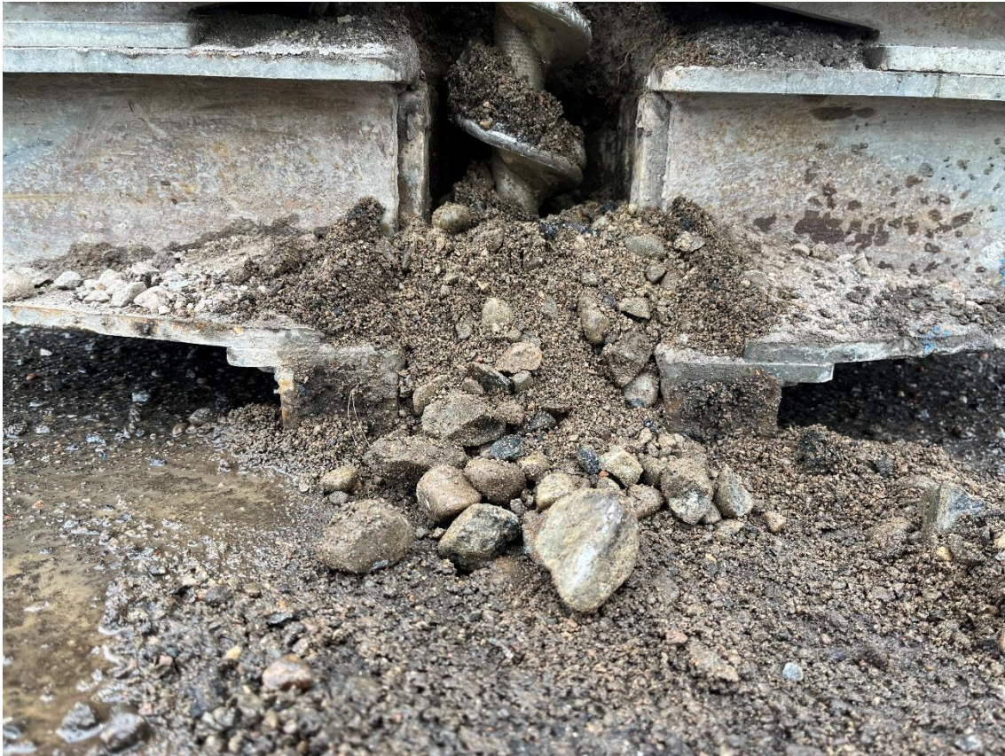
Figur 3 Bild från skruvprovtagning i 23B03 av isälvs sediment 2023-03-14 på Slussholmen.
