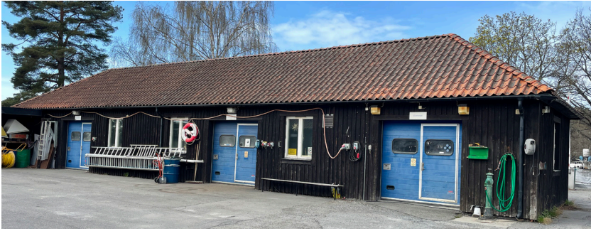
Byggnad A. Befintlig fasad mot öster, verkstadsgård.
