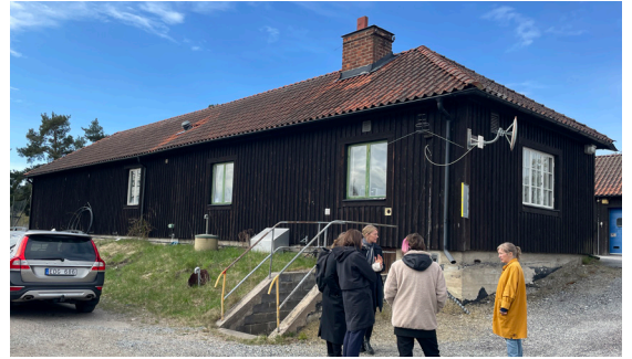
Byggnad B. Befintlig fasad mot öster, sluss.
