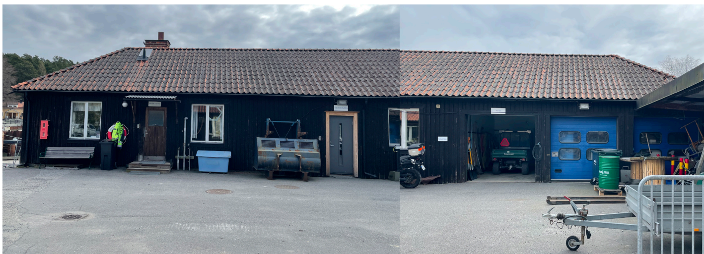
Lotsuddens västra byggnad, byggnad B. Befintlig fasad mot väster, verkstadsgård.
