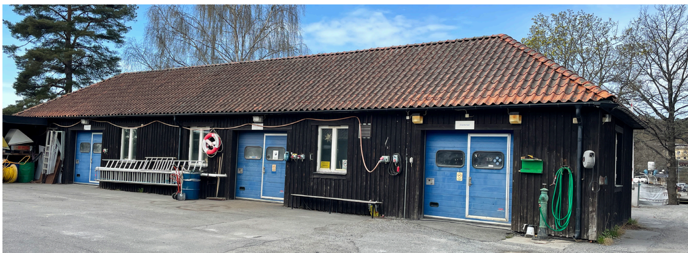
Lotsuddens västra byggnad, byggnad A. Befintlig fasad mot öster, verkstadsgård.
