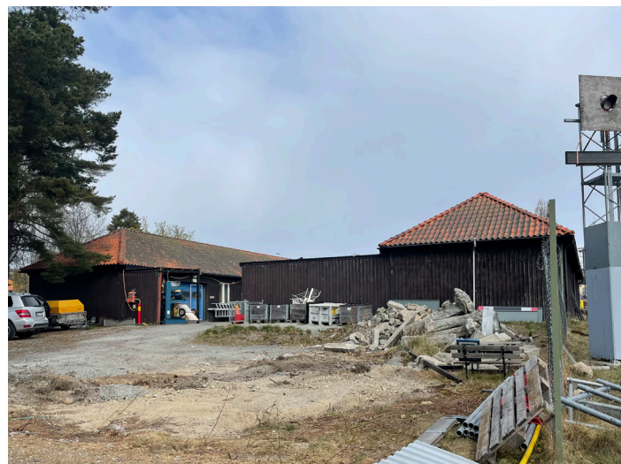
Foto som visar de södra gavlarna på sidobyggnaderna ,byggnad A och B.
