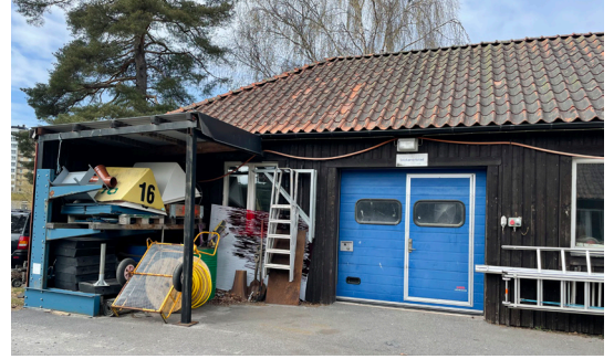
Byggnad A. Befintlig garageport mot verkstadsgård.
