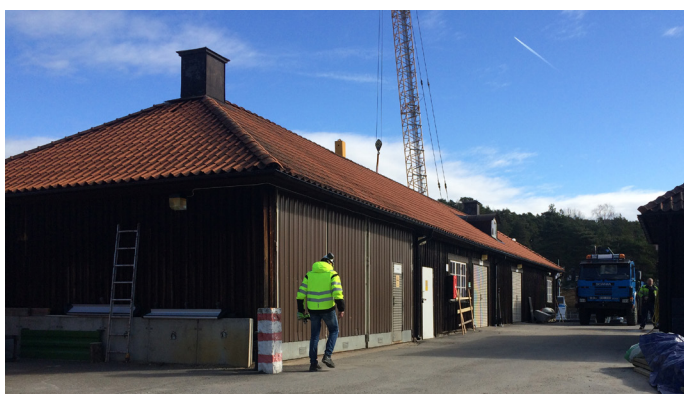
Hasses lada före demontering, t v syns det tillbyggda garaget från 1980 som i dagsläget är rivet.
