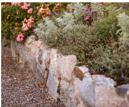
Planteringsmurar i granit av rustik karaktär tar upp höjdskillnader.
