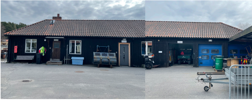
Byggnad B. Befintlig fasad mot väster, verkstadsgård.
