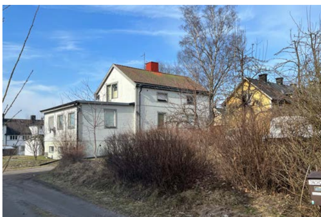
Haren 12 vid inventering imars 2024. Huvudbyggnaden har byggts ut och fasaden klätts med panel.
