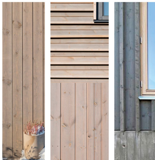
Fasad i värmebehandlat trä i ljusa neutrala kulörer och variation mellan liggande och stående panel (Wingårdhs 2025)
