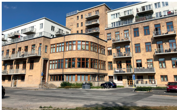
Bild på gamla Tobaksmonopolet, f.d. Industribyggnad ombyggd till bostäder
