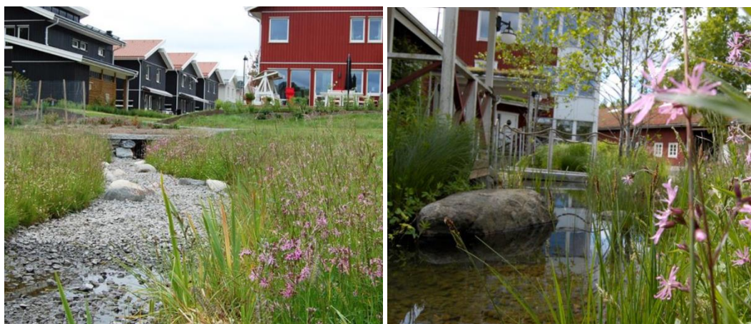
Figur 4 Exempel på torrlagt svackdike, prydd med sten och omgiven av rik, blommig strandväxtlighet (t.v.). Damm med permanent vattenspegel (t.h.)
