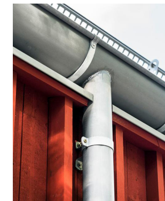
Varsamt utformade detaljer och tekniska lösningar
