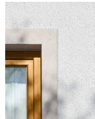
Puts med stenomfattningar i hotellets sockelväning
