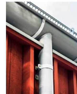
Varsamt utformade detaljer och tekniska lösningar
