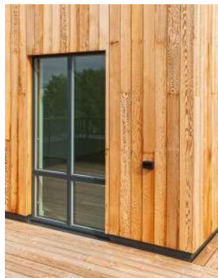
Slät träpanel som möter tvåluftsfönster
