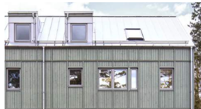
Slät träpanel med ribbor som möter tvåluftsfönster och plåttak med takkupor
