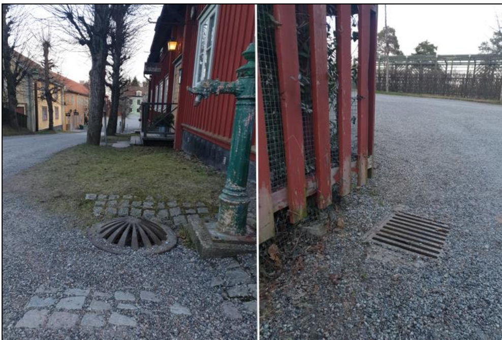
Figur 11. Kupolbrunn samt rännstensbrunn som är belägna söder om planområdet
