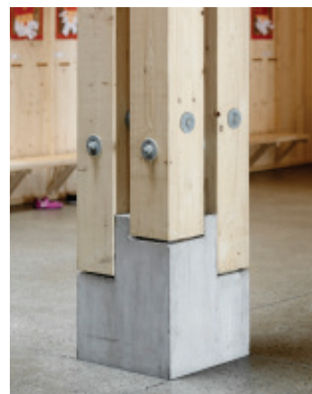
Omsorgsfulla möten mellan konstruktion och mark.
