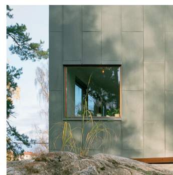
Bandtäckta plåt i tak och fasad.
