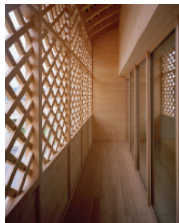
Raster, både i konstruktion och fasad, skapar en filtrering av ljus.
