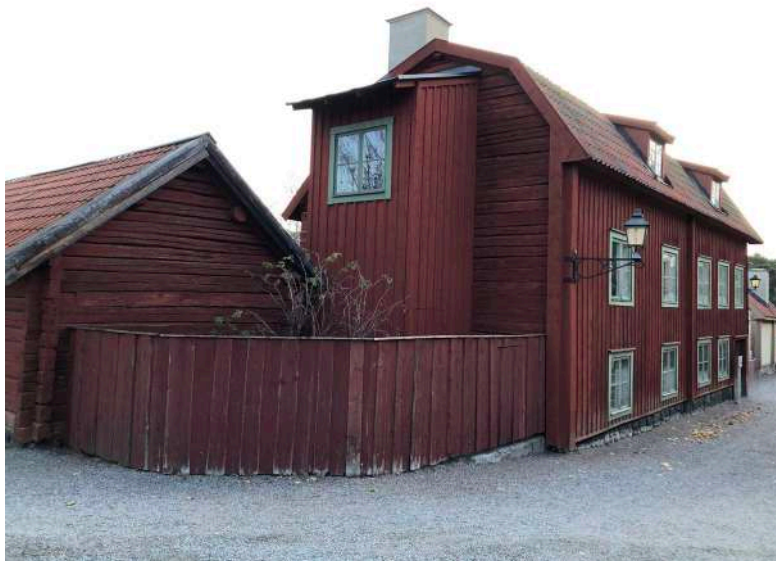
Det slutna hantverkskvarteret med det Elmrothska garveriet som största byggnadsvolym. I 1800-tals staden fanns enstaka större volymer. Bebyggelsen är timrad och delvis panelad. Ett nytt trapphus har byggts på garveriets gavel som utrymningsväg.
