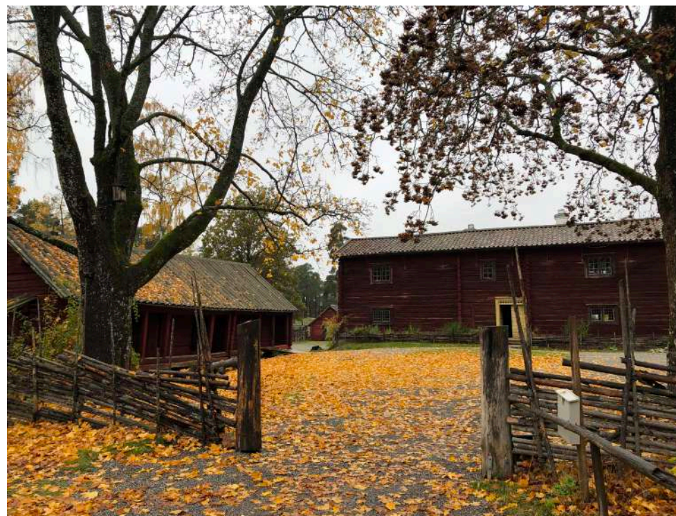
Råbygården utgör huvudbyggnaden och den största volymen i gårdsmiljön. Äldre bodar bildar ett gårdstun framför gården. Byggnaderna är uppförda i liggtimmerteknik. Gården har tegeltak medan bodarna har brädtak. I området finns gårdesgårdar runt hagar, entré och vid fägator.
