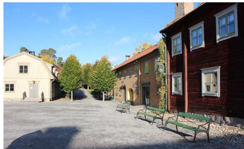
Torget i Staden med tre exempel på fasadutformning. Stående locklistpanel, spritputsad lättbetong och liggande timmer med täckta knutar. Samtliga byggnader har lertegeltak. På bilden syns det timrade Kullmanska huset, Kanslibyggnaden med gångvalvet och Lindblomska huset..
