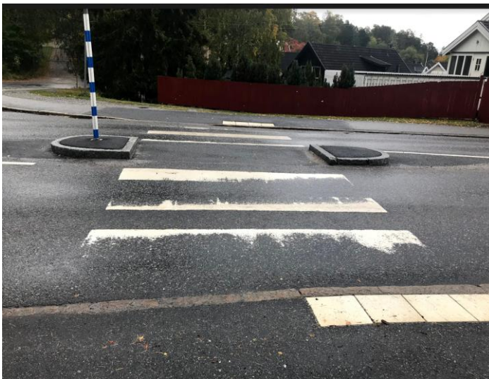
Figur 33 - Övergångsstället bredvid busshållplatsen Torekällberget
