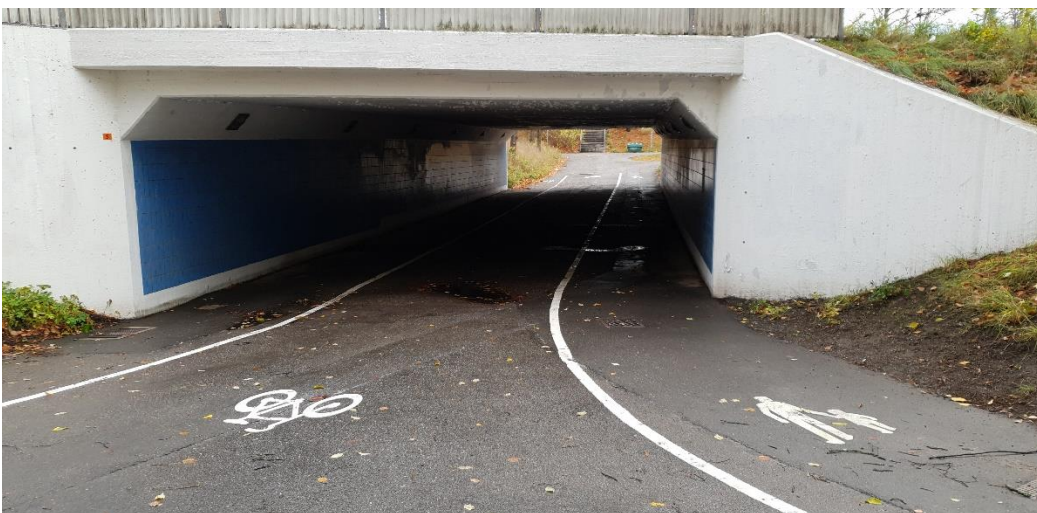
Figur 4 - Befintligt. Vy mot öster, cirka 100 meter norr om planområdet. Från platsbesök 181031
