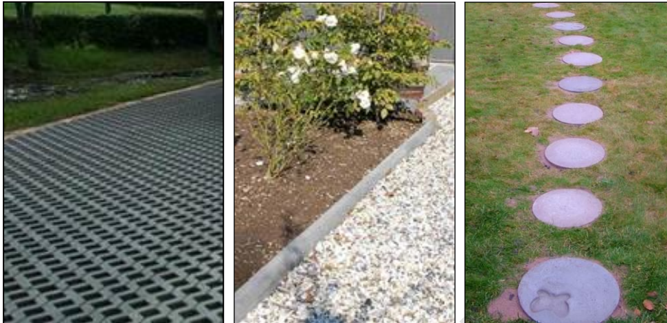
Figur 14. Yta med hålsten av betong, makadambelagd gång, samt gångstig med gräs och ett fåtal gångplattor (Norconsult)
