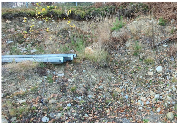
Figur 4. En avschaktad slänt indikerar att jorden innehåller främst sand, grus och sten.
